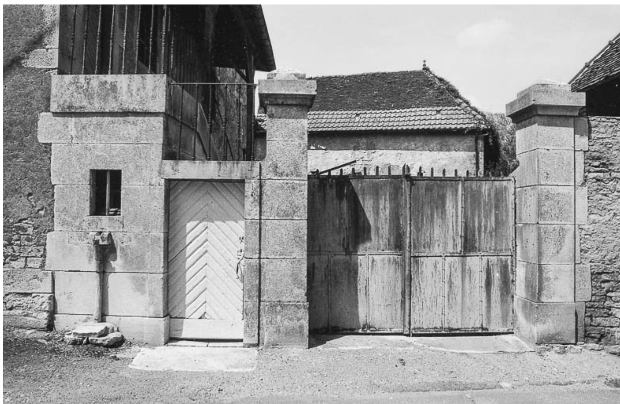
Vue rapprochée du portail d'entrée.
