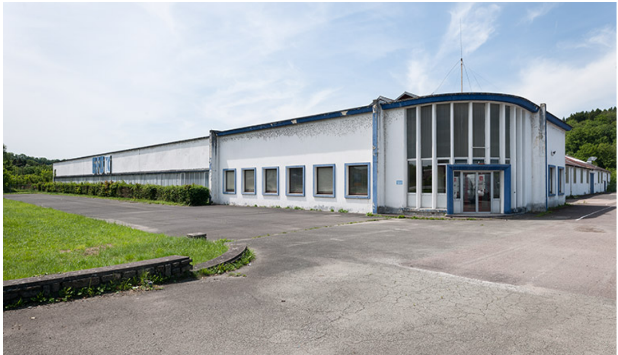
Façade est et entrée de l'usine.
