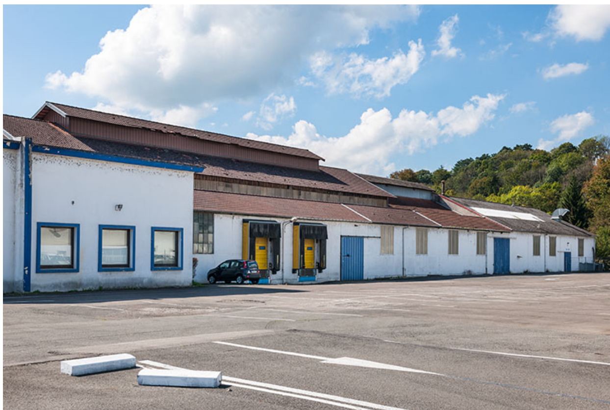
Façade nord vue de trois quarts.
