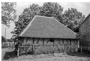
Dépendance. Phot. Guy Forestier IVR43_19753900133Z
