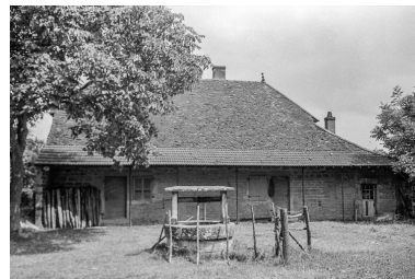
Bâtiment d'habitation : façade antérieure. Phot. Guy Forestier IVR43_19753900132Z
