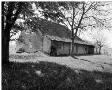
Bâtiment d'habitation : façade postérieure. Phot. Bernard Lardière IVR43_19793900311X
