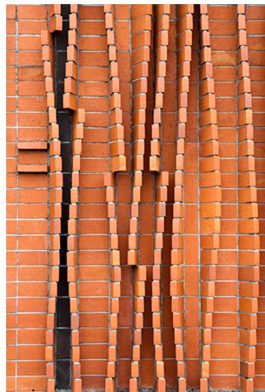
Détail du mur sud. Phot. Sonia Dourlot IVR43_20143900834NUC2A
