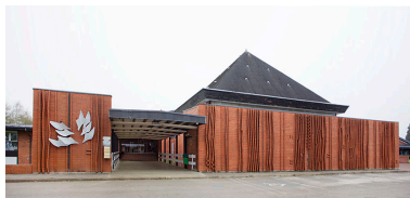
Vue d'ensemble de l'oeuvre de face. Phot. Sonia Dourlot IVR43_20143900818NUC2A
