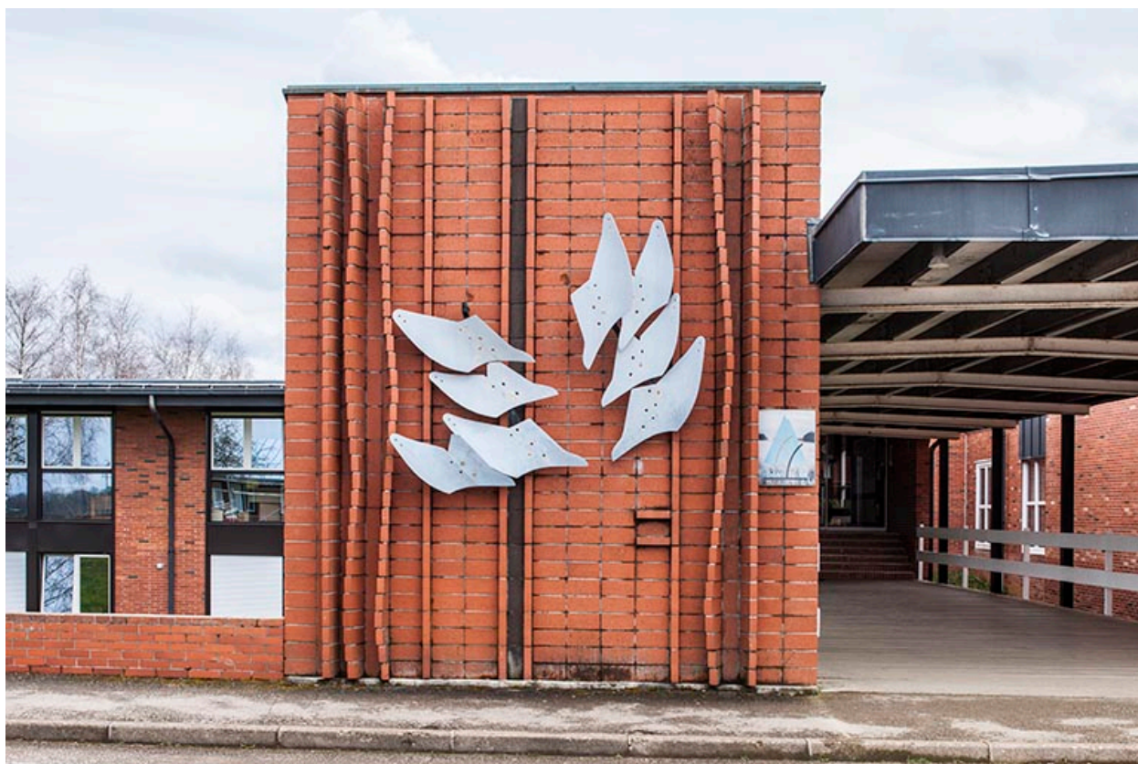
Mur nord vu de face.
