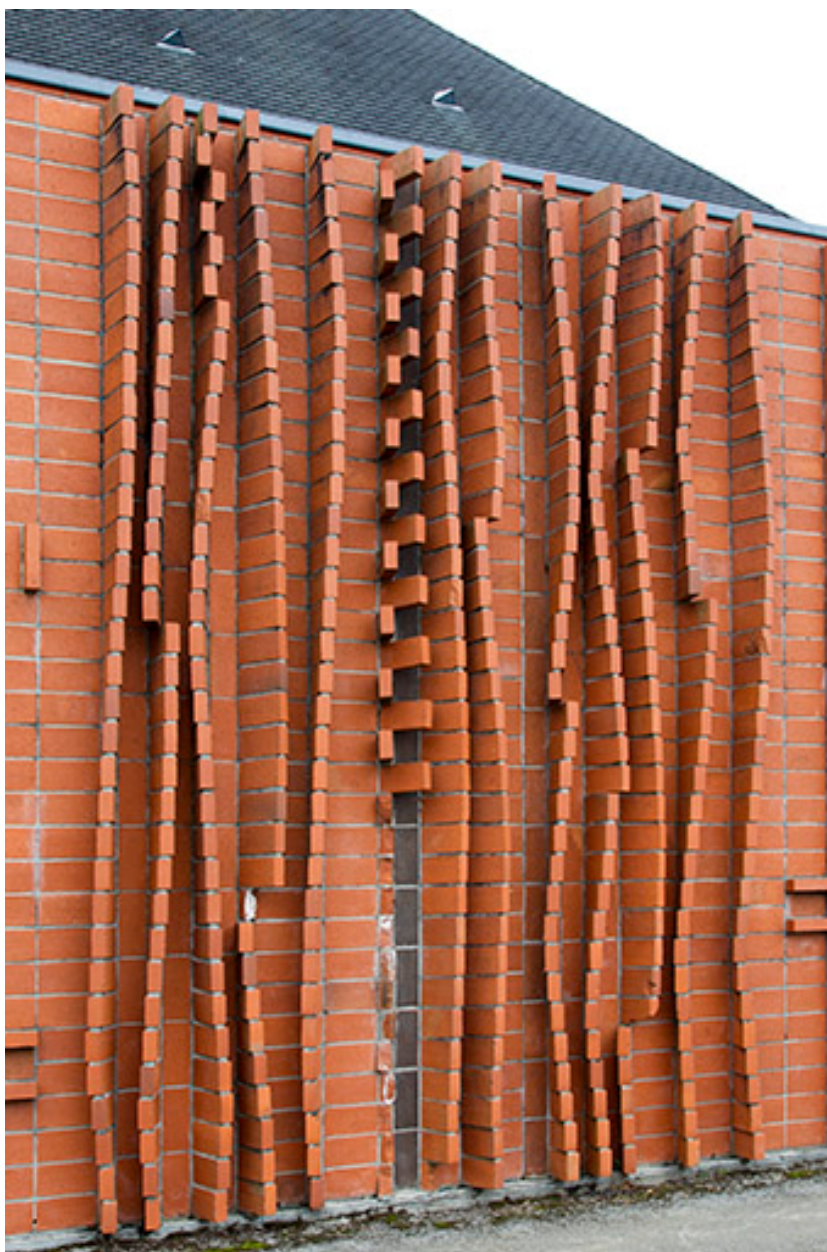
Détail du mur sud. Vue de trois-quart.
