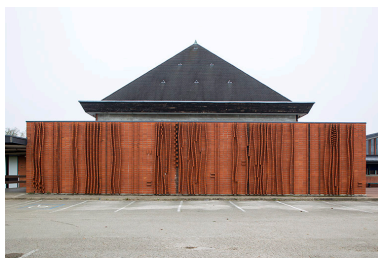
Vue de face du long mur sud. Phot. Sonia Dourlot IVR43_20143900824NUC2A
