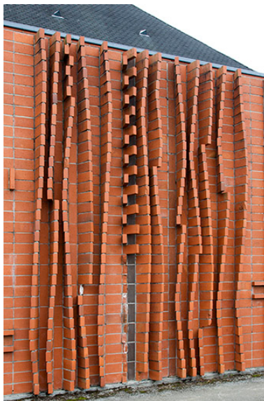
Détail du mur sud. Vue de trois-quart. Phot. Sonia Dourlot IVR43_20143900832NUC2A
