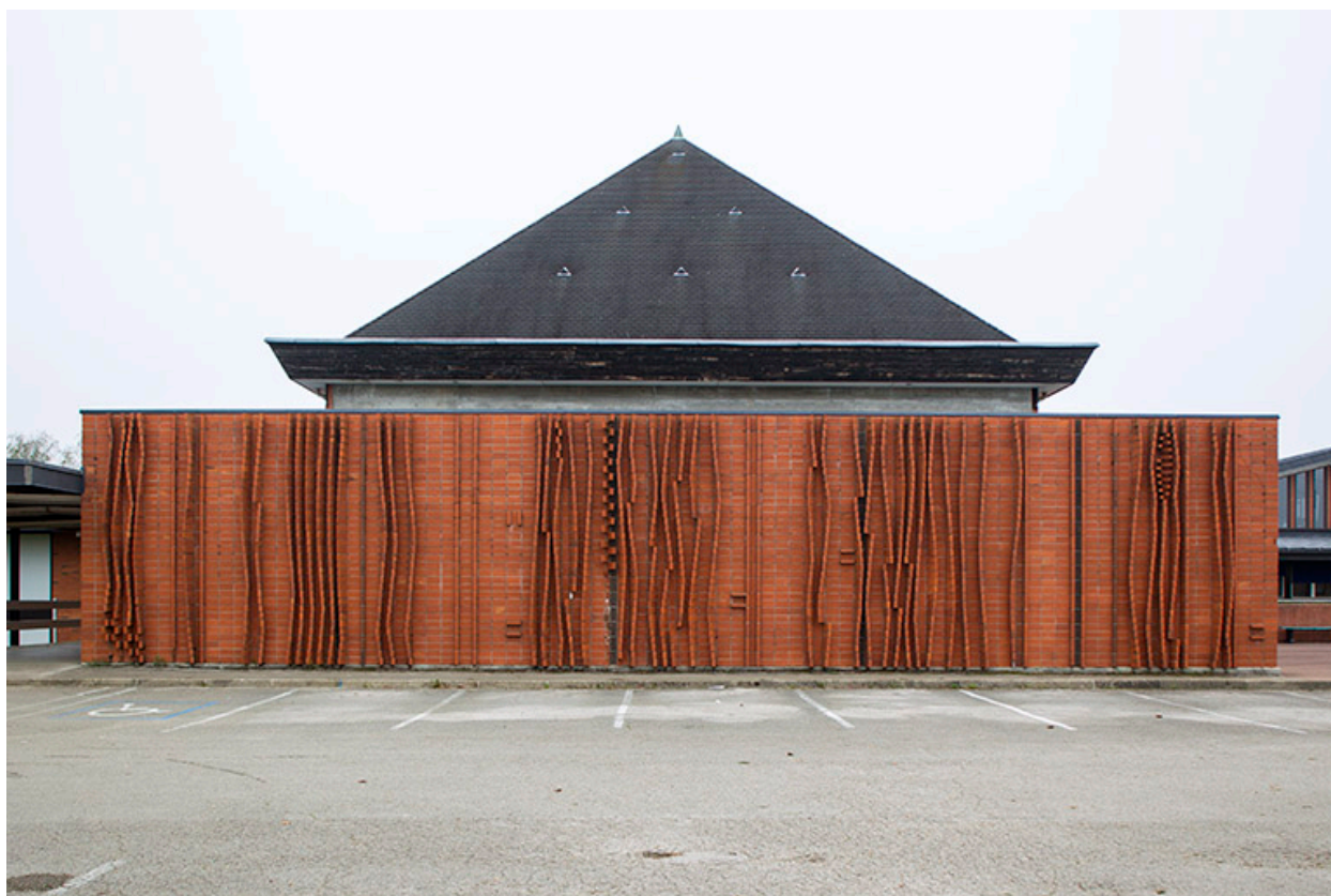
Vue de face du long mur sud.
