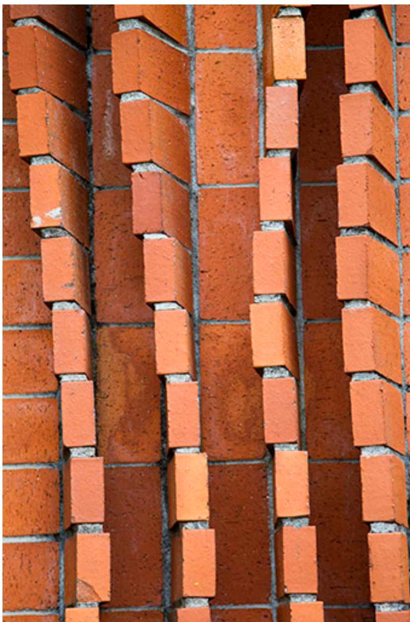
Détail du mur sud. Vue rapprochée.
