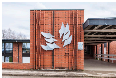
Mur nord vu de face. Phot. Jérôme Mongreville IVR43_20143900001NUC4A
