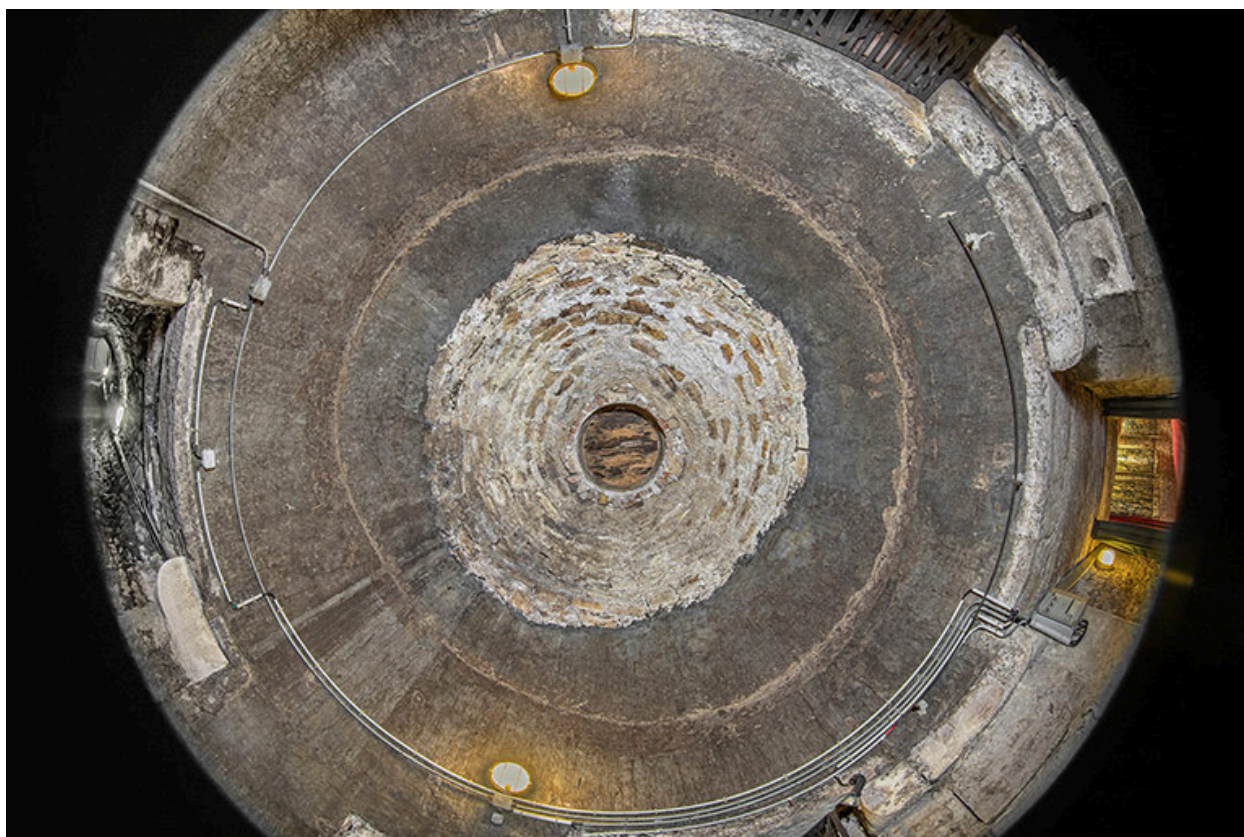
Plafond du niveau inférieur.
