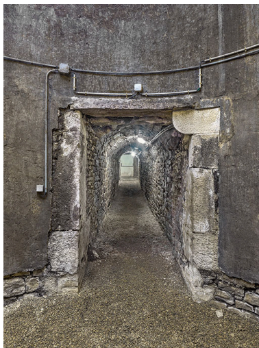
Niveau inférieur et la galerie souterraine sous le rempart. Phot. Thierry Kuntz IVR26_20232100323NUC4A
