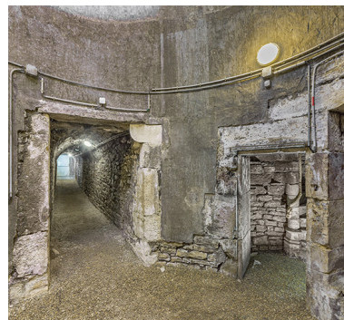
Niveau inférieur : à gauche la galerie, à droite la porte vers l'escalier de la tour. Phot. Thierry Kuntz IVR26_20232100324NUC4A
