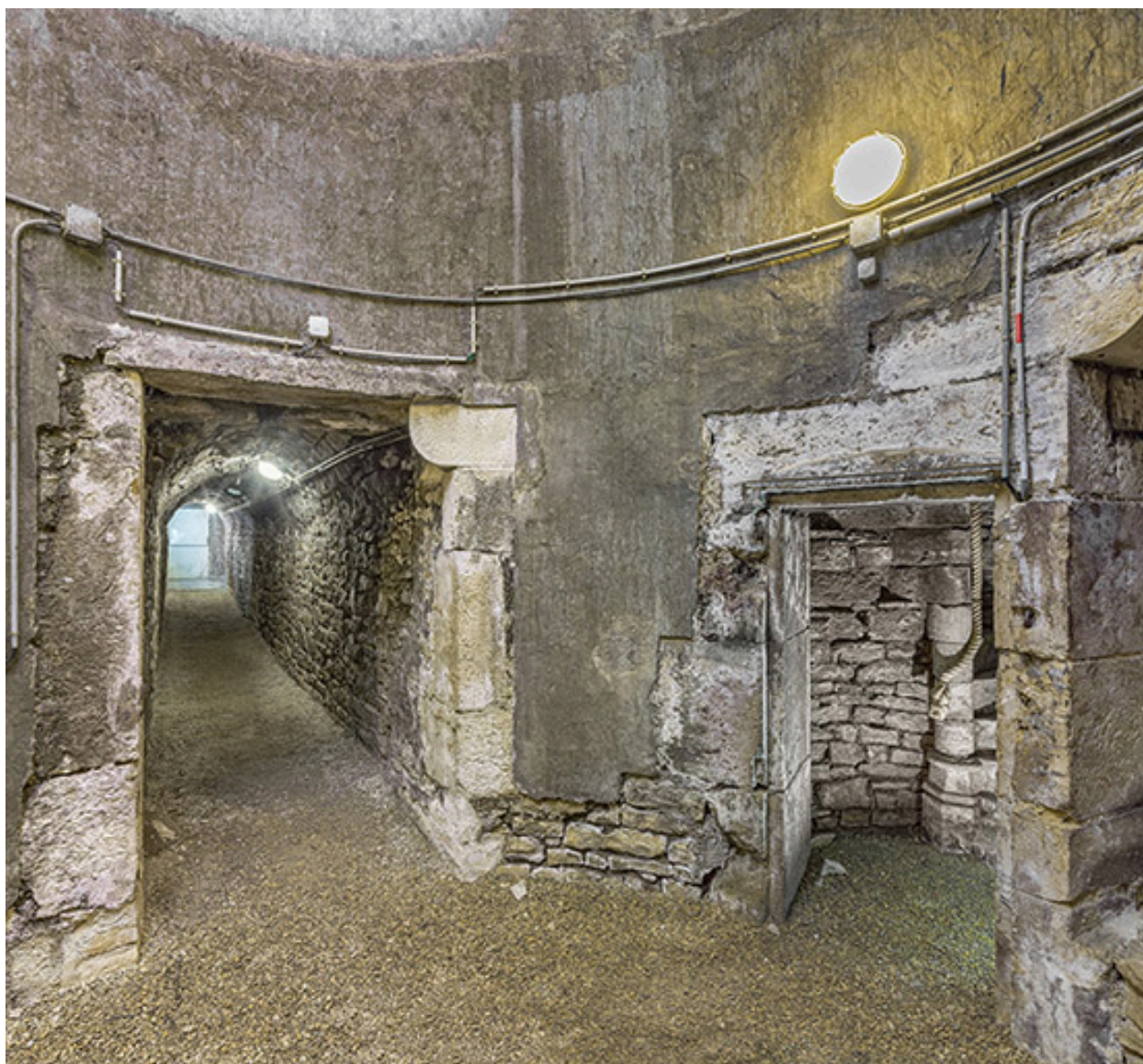
Niveau inférieur : à gauche la galerie, à droite la porte vers l'escalier de la tour.
