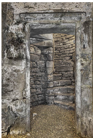
Première volée de l'escalier en vis. Phot. Thierry Kuntz IVR26_20232100325NUC4A
