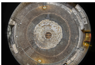
Plafond du niveau inférieur. Phot. Thierry Kuntz IVR26_20232100326NUC4A
