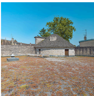
La tour des Cordeliers, englobée dans la tour de l'hôtel-Dieu. Phot. Thierry Kuntz IVR26_20242100308NUC4A
