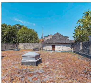
La tour des Cordeliers, englobée dans la tour de l'hôtel-Dieu. Phot. Thierry Kuntz IVR26_20242100293NUC4A
