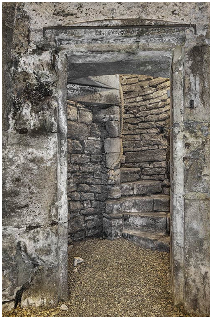
Première volée de l'escalier en vis.
