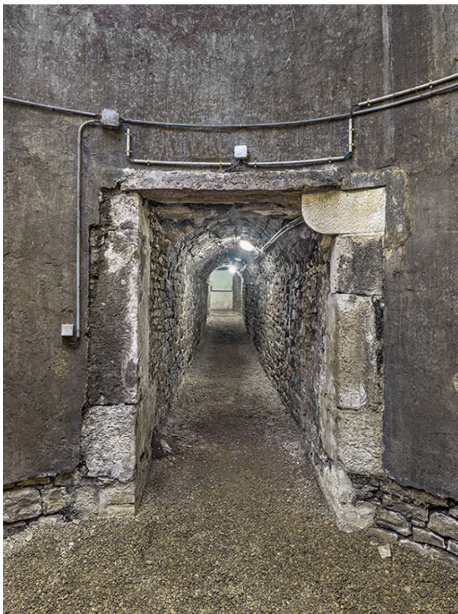
Niveau inférieur et la galerie souterraine sous le rempart.
