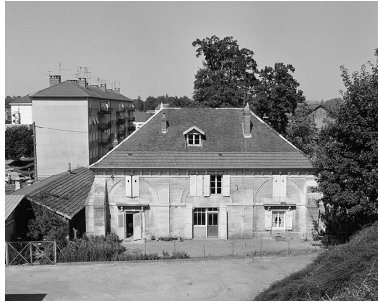
Façade antérieure, de face. Phot. Yves Sancey IVR43_19887000173X
