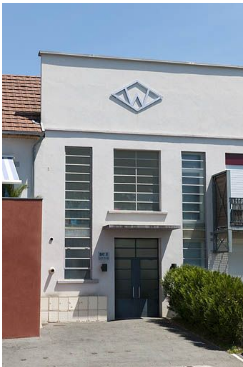
Détail de la façade occidentale.
