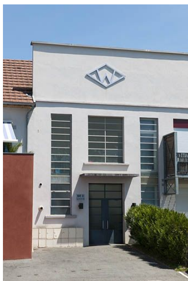
Détail de la façade occidentale.
