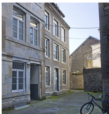
Vue de la troisième cour.
