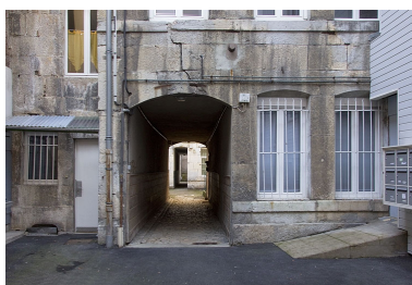
Premier logis secondaire : détail du passage cocher. Phot. Yves Sancey IVR43_20122500370NUC2A
