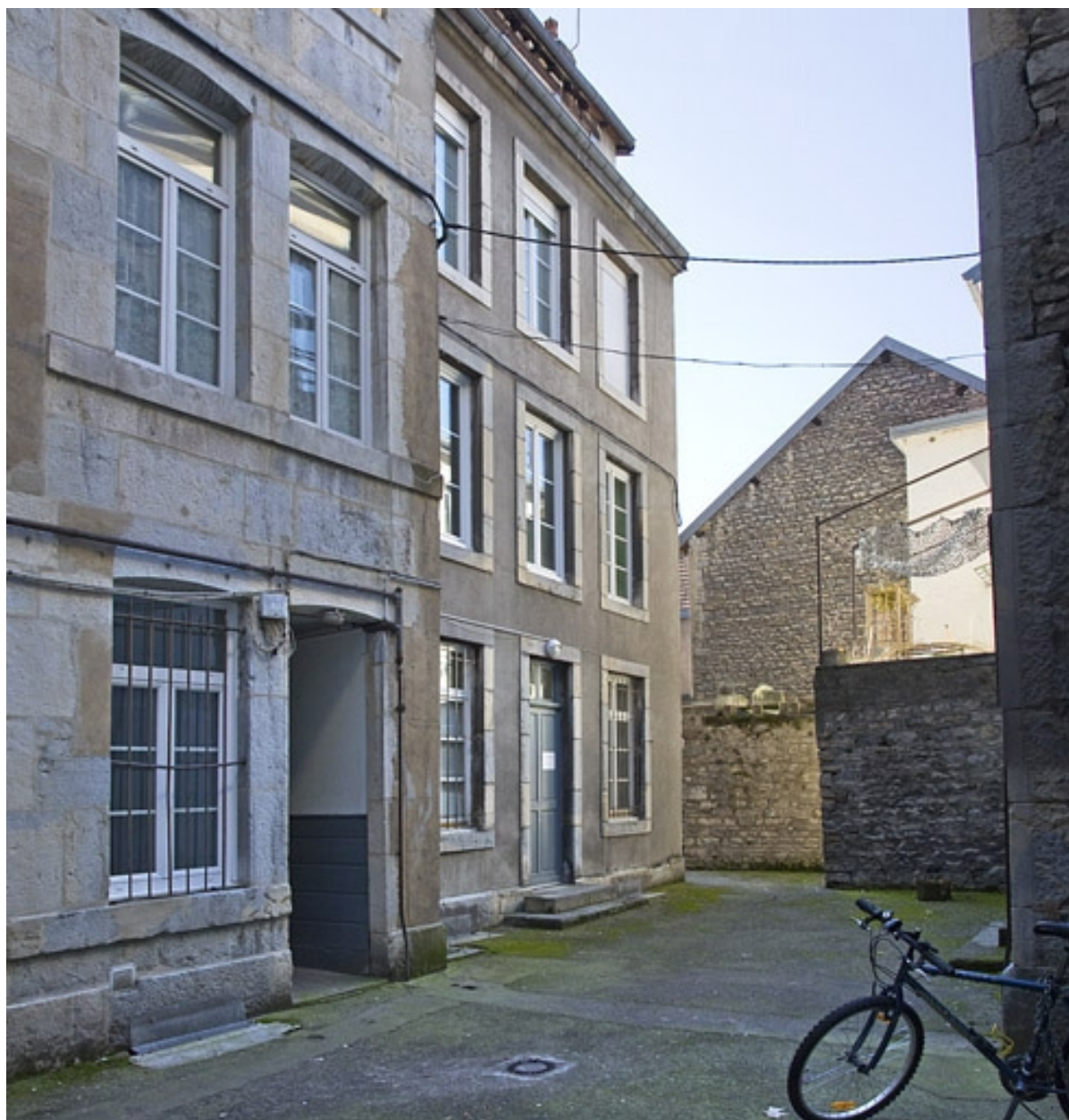
Vue de la troisième cour.
