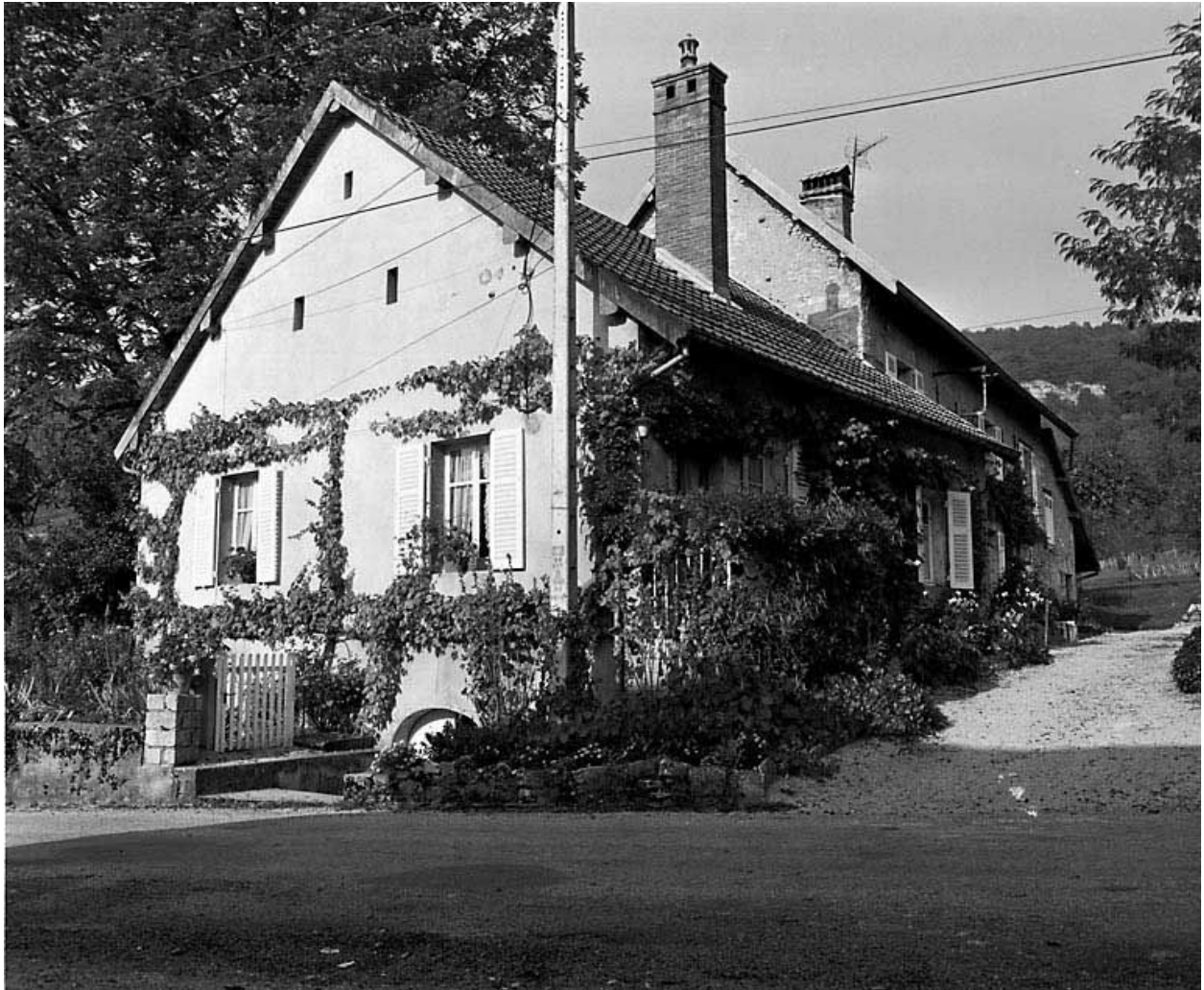
Maison de vigneron située rue du Mont d'Oeil.
