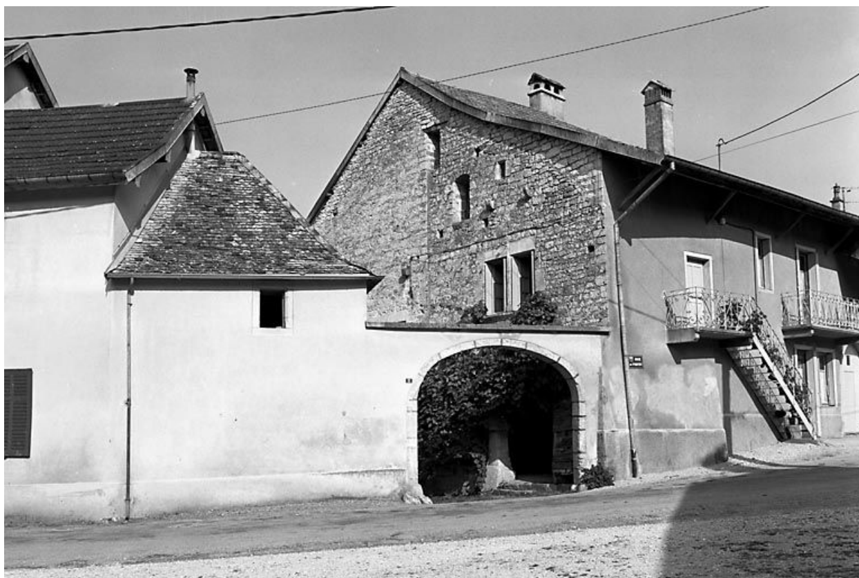
Maison de vigneron située rue du Pontot.
