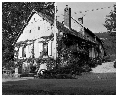
Maison de vigneron située rue du Mont d'Oeil. Phot. Yves Sancey IVR43_19802501068X
