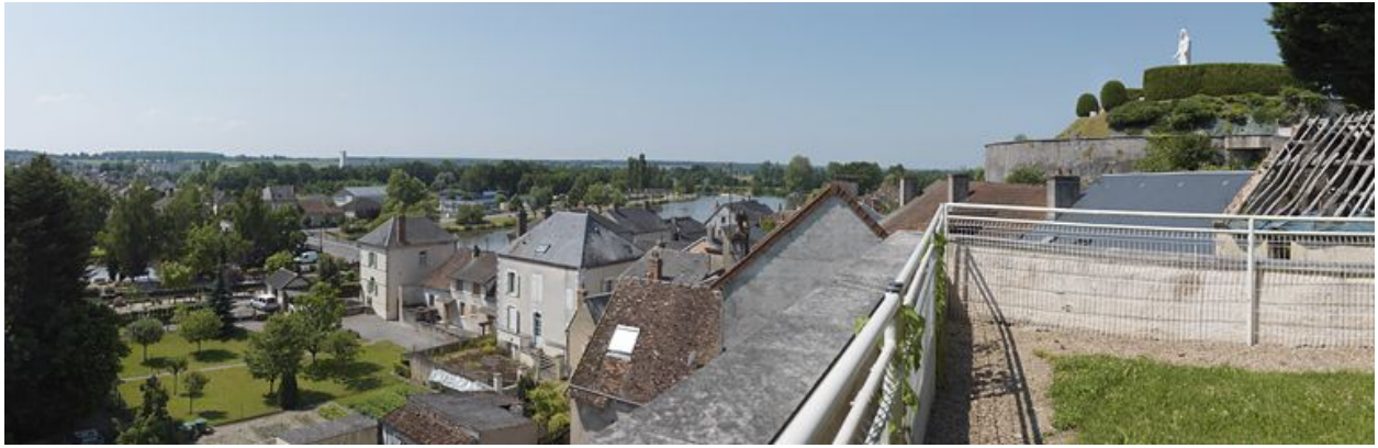
Vue d'ensemble du site d'écluse et du canal.
