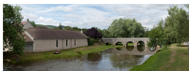
Vue du pont ancien sur l'Ouche. Phot. Pierre-Marie Barbe-Richaud IVR26_20112103561NUC4AQ
