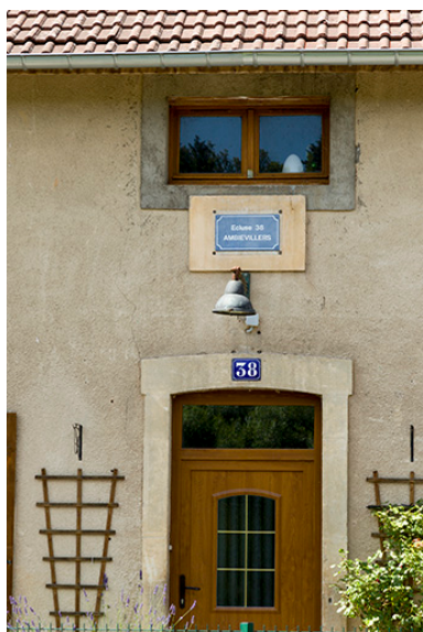
Plaque d'identification de l'écluse. Phot. Sonia Dourlot IVR43_20157000901NUC2A
