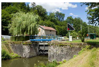
Vue d'ensemble depuis l'aval. Phot. Sonia Dourlot IVR43_20157000898NUC2A
