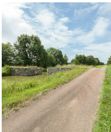
Vue du pont.
