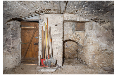
Le cellier, vu en direction de la porte. Phot. Nicolas Waltefaugle IVR26_20258900272NUC4A
