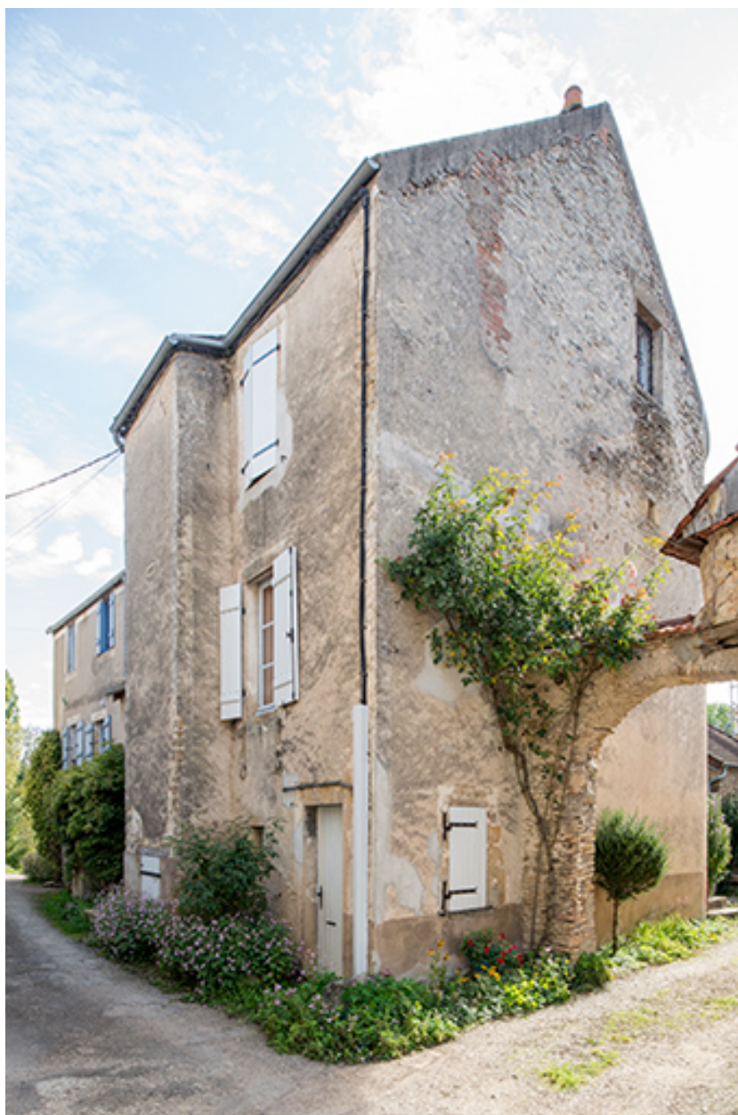
Le corps de logis, depuis la rue.
