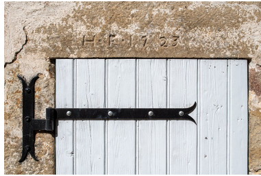
Le linteau de l'une des fenêtres du four à pain. Phot. Nicolas Waltefaugle IVR26_20268900317NUC4A
