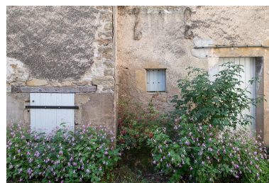
Le four à pain (entrée à droite, remise à bois à gauche). Phot. Nicolas Waltefaugle IVR26_20258900269NUC4A
