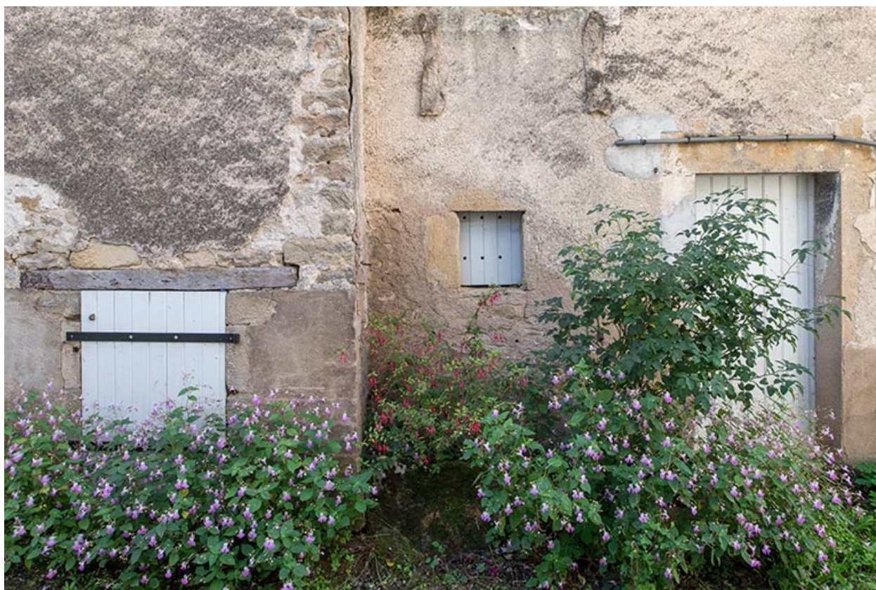
Le four à pain (entrée à droite, remise à bois à gauche).
