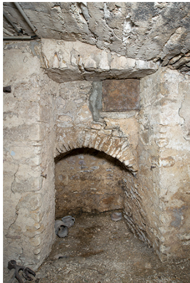
Le cellier, détail de la voûte supportant l'escalier extérieur. Phot. Nicolas Waltefaugle IVR26_20258900273NUC4A
