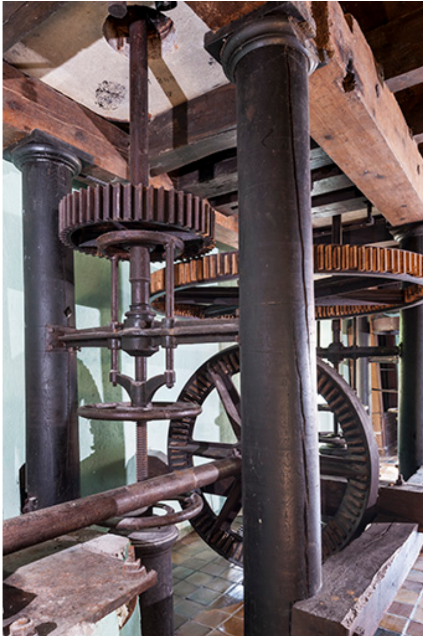
Beffroi est. Détail de la transmission.
