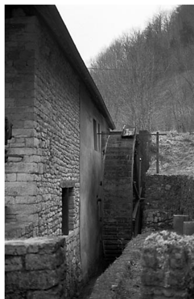
Façade latérale droite : la roue hydraulique verticale en 1980. Phot. Liliane Hamelin IVR43_20002500204Z
