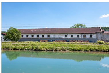
Atelier de pliage, depuis l'ouest. Phot. Jérôme Mongreville IVR43_20132500460NUC4A
