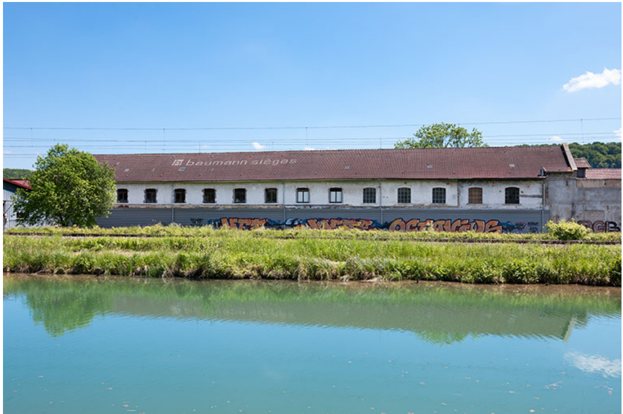
Atelier de pliage, depuis l'ouest.
