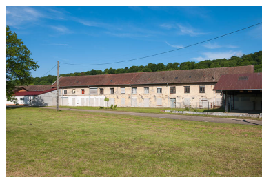
Atelier de pliage. Façade ouest. Phot. Jérôme Mongreville IVR43_20132500458NUC4A
