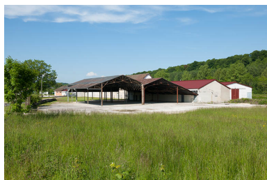
Entrepôt industriel et ateliers depuis l'est. Phot. Jérôme Mongreville IVR43_20132500457NUC4A
