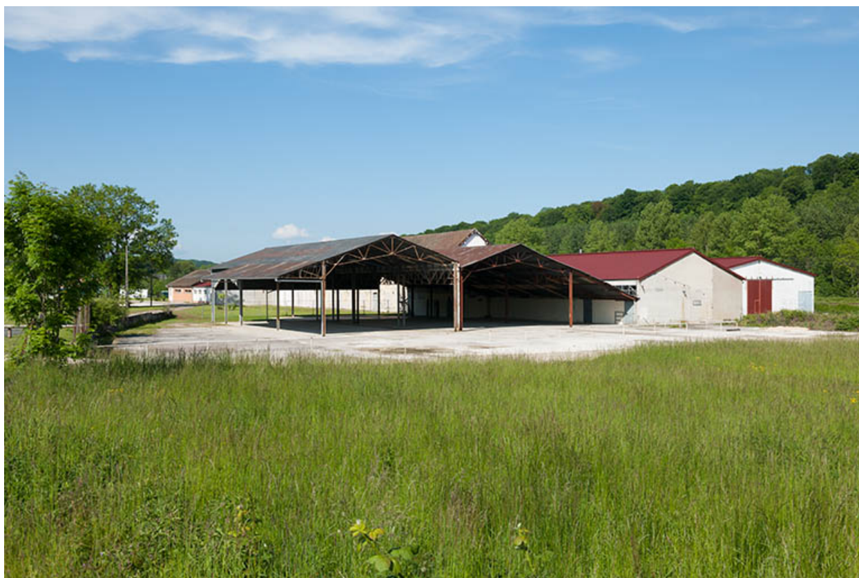
Entrepôt industriel et ateliers depuis l'est.
