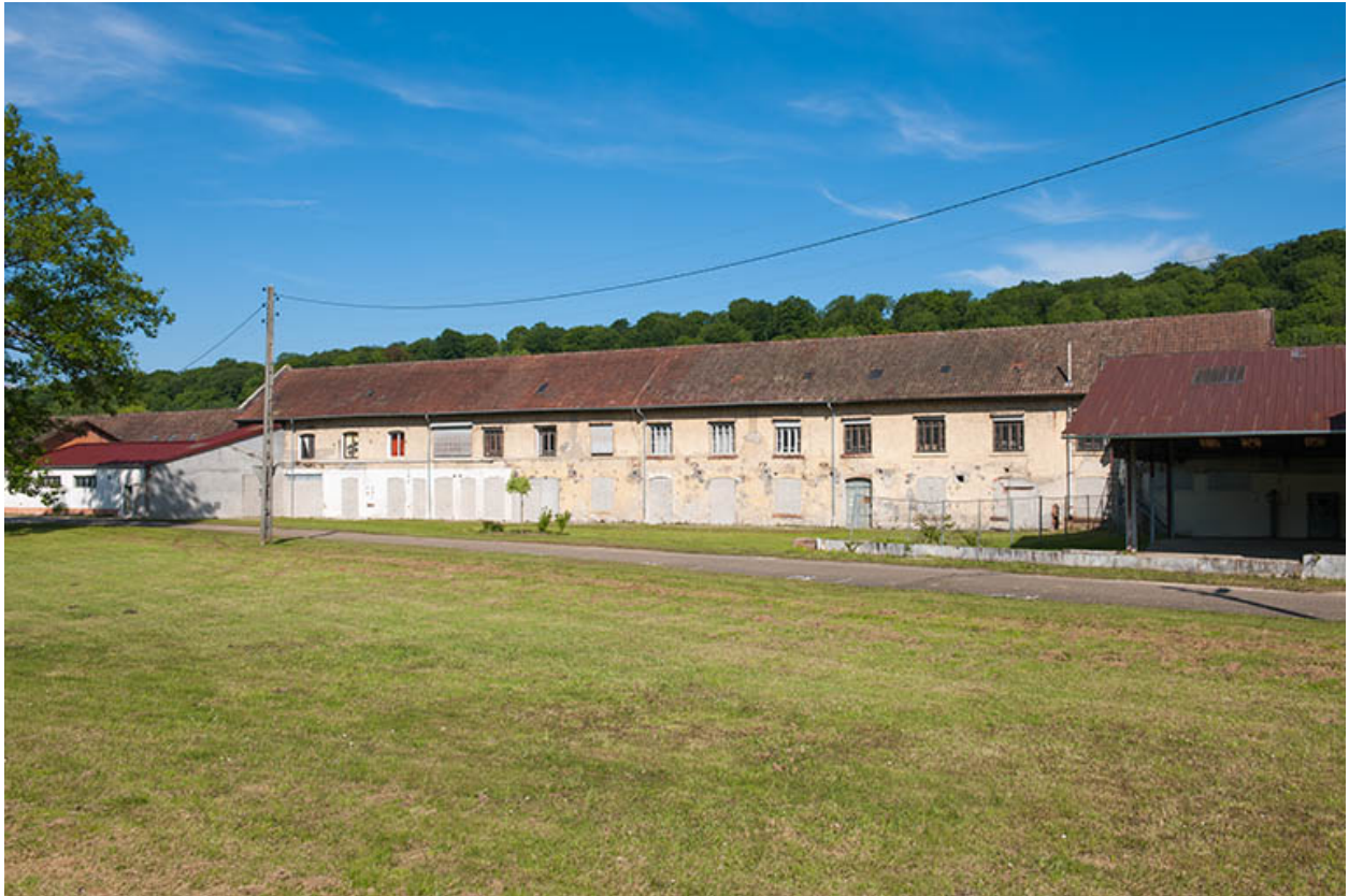
Atelier de pliage. Façade ouest.
