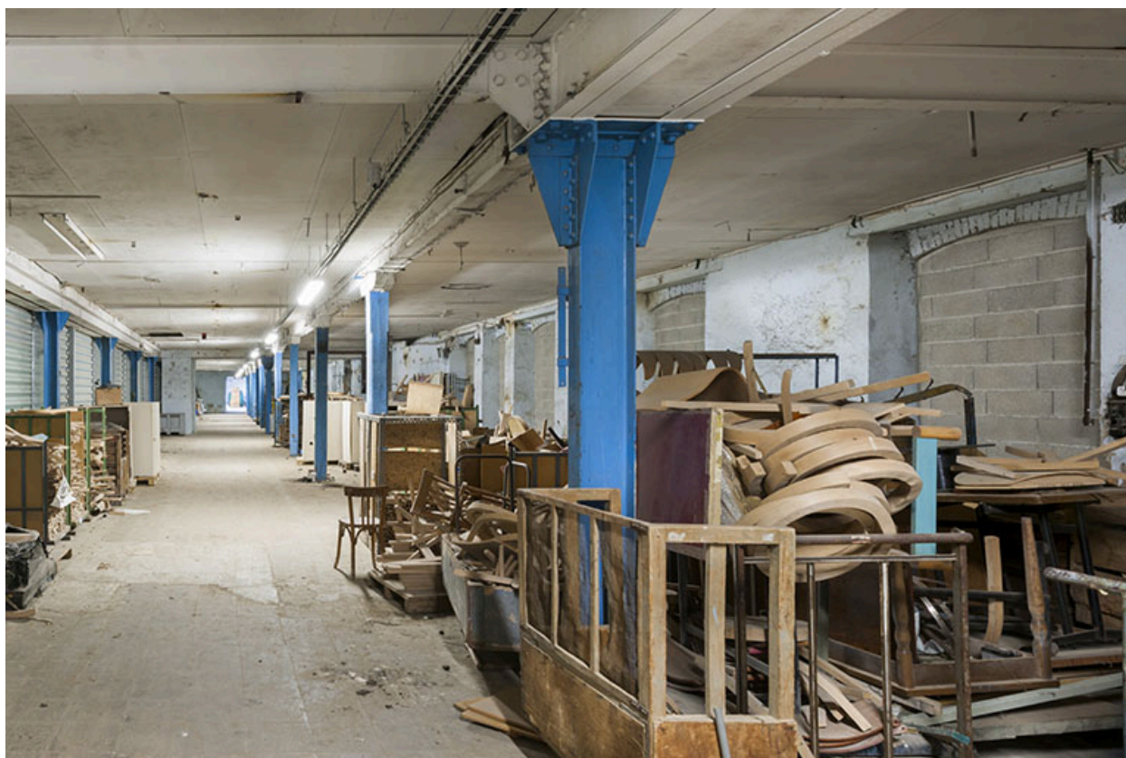
Atelier de pliage. Vue intérieure depuis le sud.
