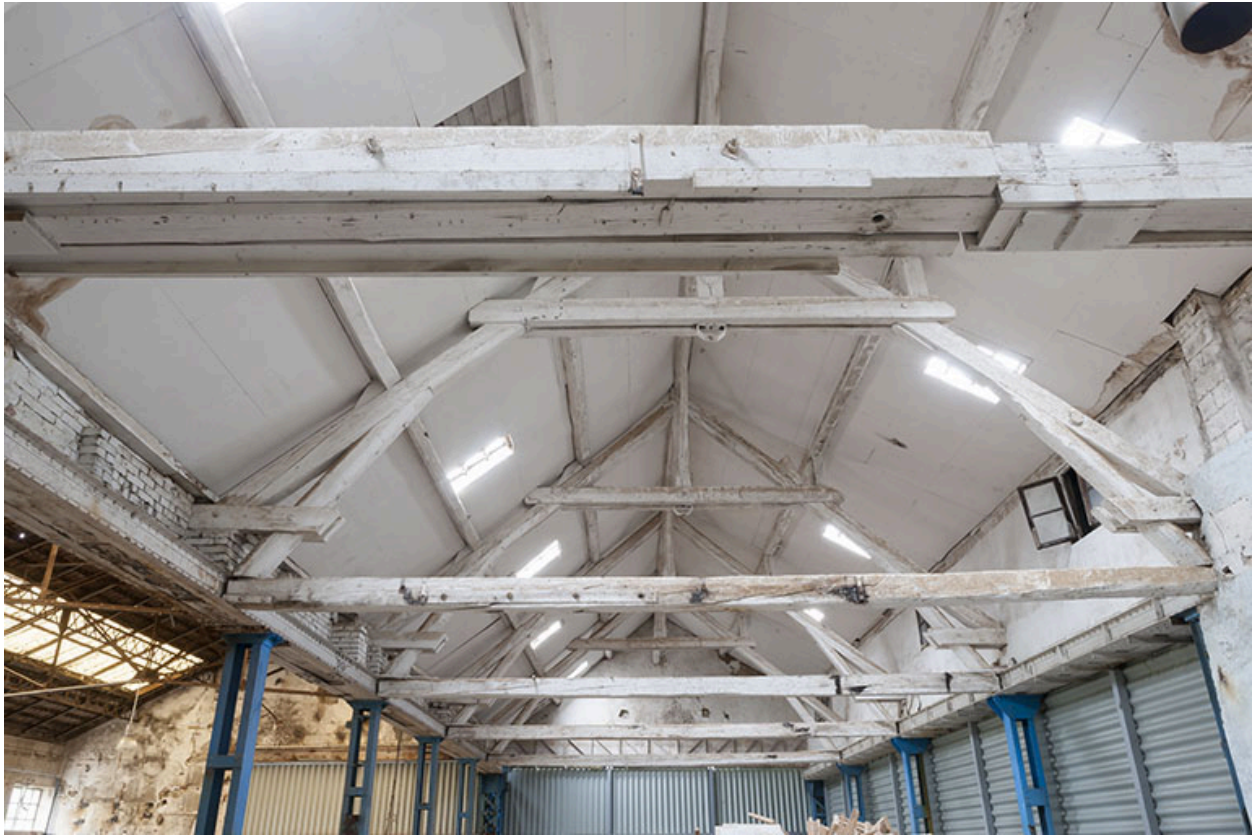
Charpente de l'atelier d'usinage.
