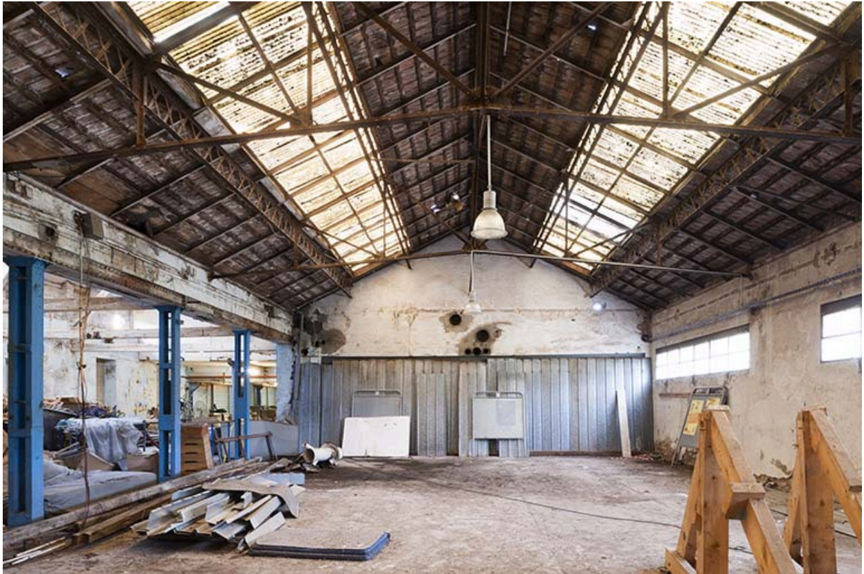
Atelier d'usinage. Travée est.
