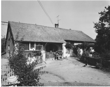
Façade antérieure. Phot. Dominique Dominguez IVR43_19803900054X
