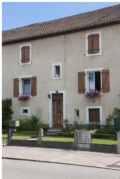
Elévation d'une façade. Phot. Jérôme Mongreville IVR43_20112502277NUC4A
