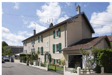
Habitation ouvrière vue de trois quarts droite. Phot. Jérôme Mongreville IVR43_20112502272NUC4A
