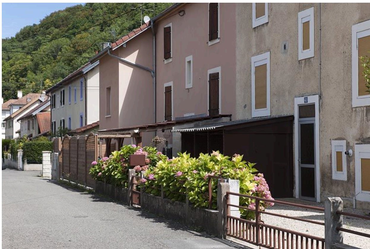
Façades ouest d'habitations ouvrières.
