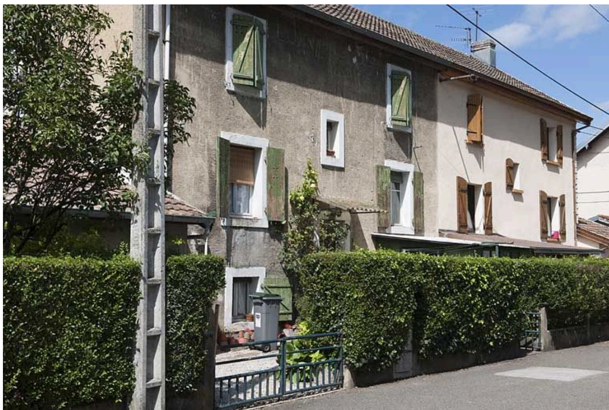
Détail d'une façade d'un habitation.
