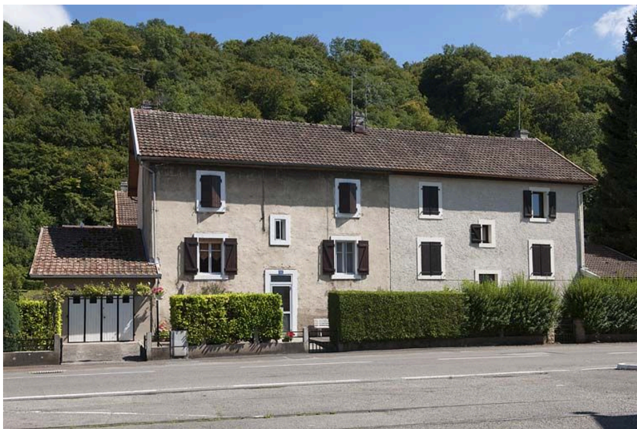
Façade ouest d'une habitation ouvrière.
