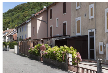
Façades ouest d'habitations ouvrières. Phot. Jérôme Mongreville IVR43_20112502274NUC4A
