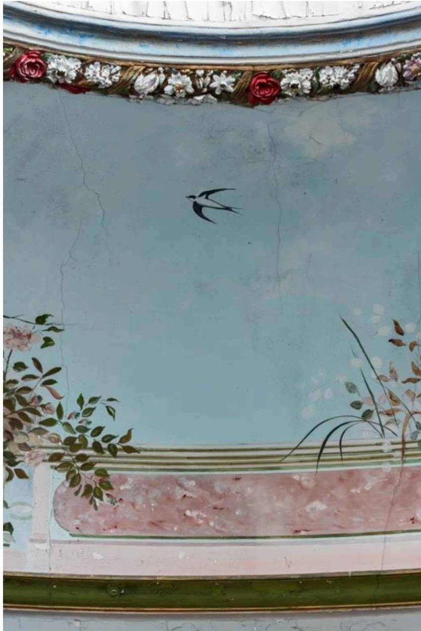
Salle, décor peint de la fausse coupole : garde-corps et hirondelle.
