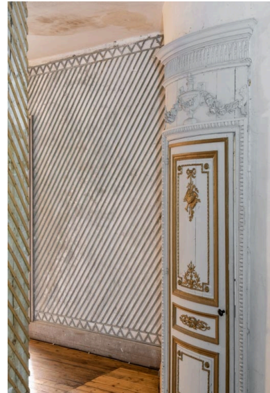
Couloir desservant la salle : décor de treillages en bois. Phot. Pierre-Marie Barbe-Richaud IVR26_20212100524NUC4A
