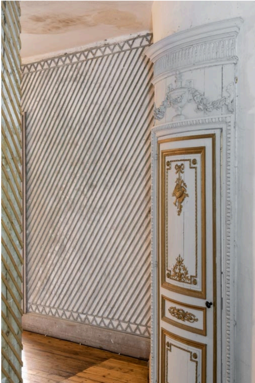
Couloir desservant la salle : décor de treillages en bois.
