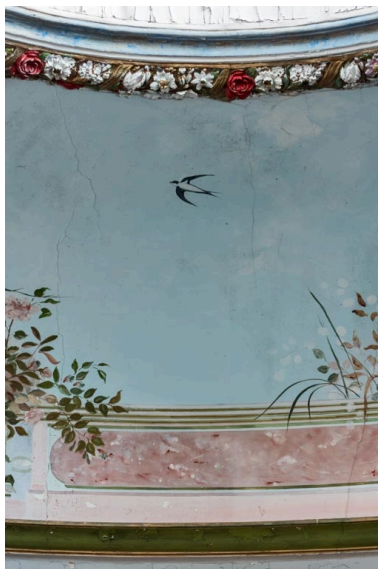
Salle, décor peint de la fausse coupole : garde-corps et hirondelle. Phot. Pierre-Marie Barbe-Richaud IVR26_20212100526NUC4A
