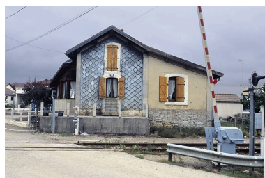
Façade sud (côté voie). Phot. Yves Sancey IVR43_20043900268ZA
