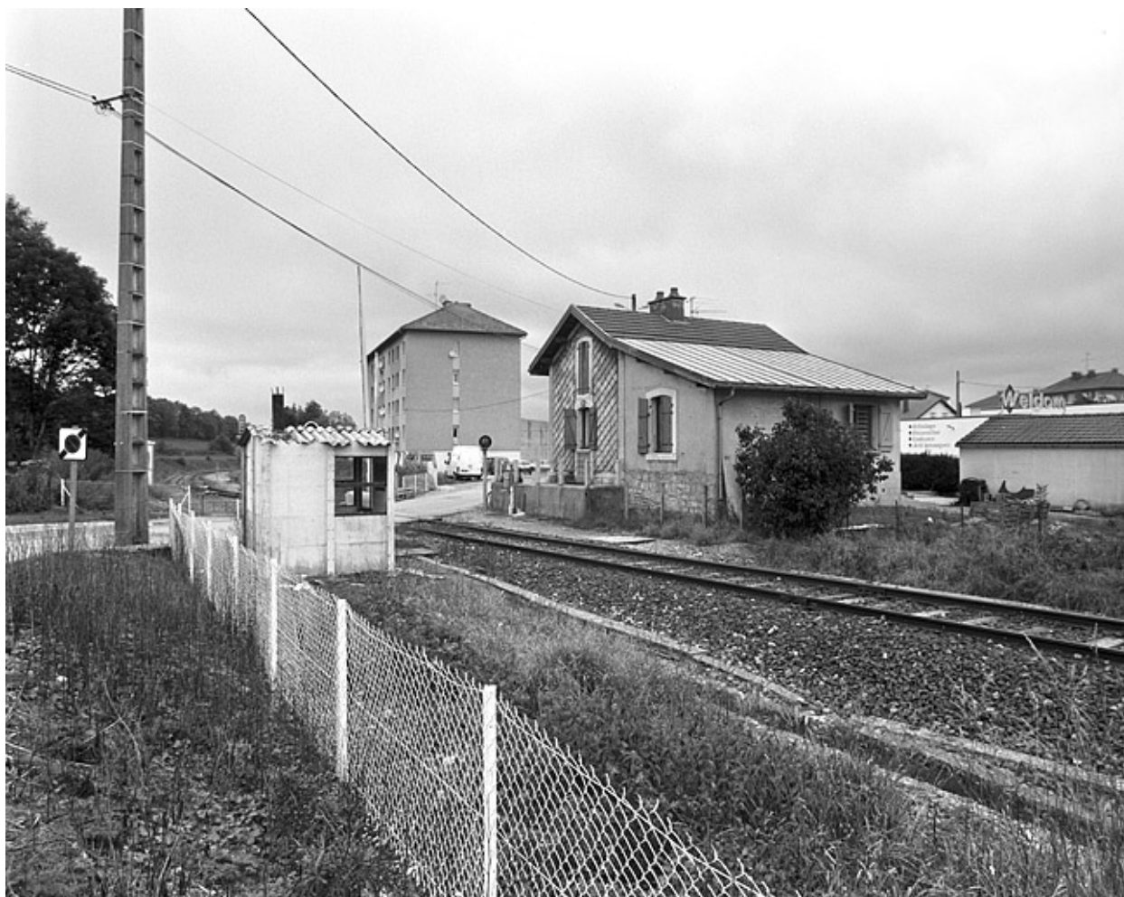
Vue d'ensemble, depuis le sud-est (côté La Cluse).
