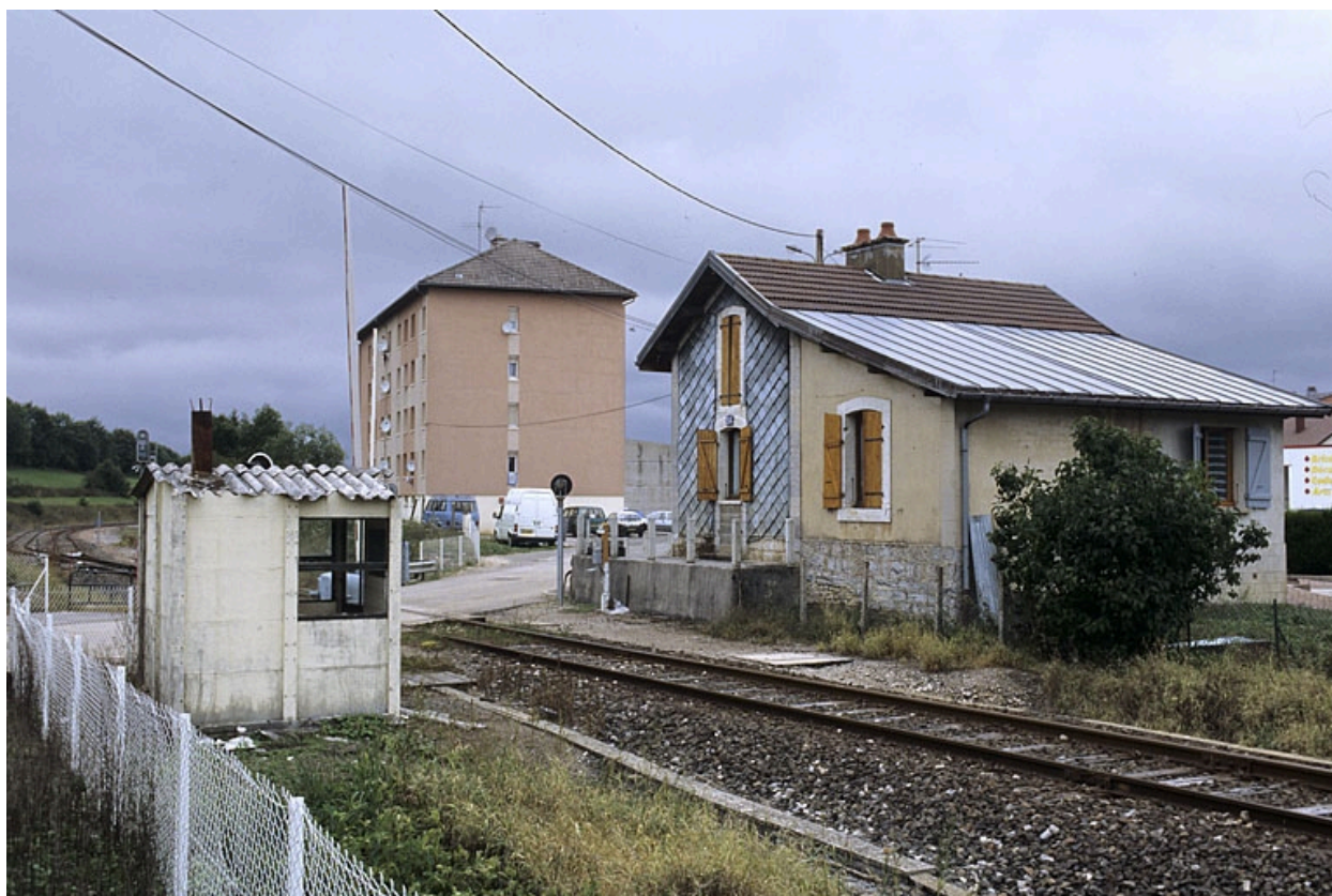
Façades sud et est.
