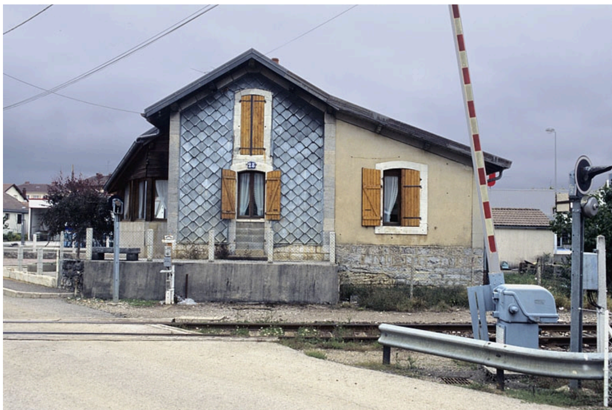
Façade sud (côté voie).
