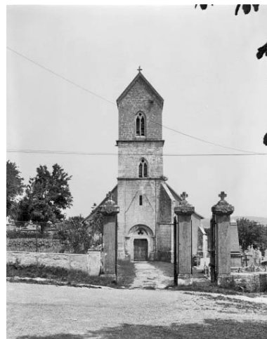
Élévation antérieure. Phot. Yves Sancey IVR43_19829000255V
