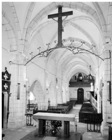
La nef vue du chœur. Phot. Yves Sancey IVR43_19829000261V
