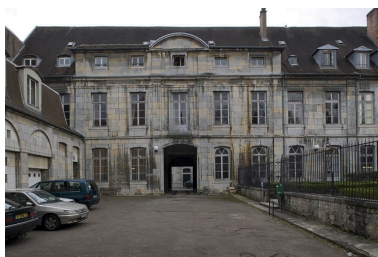
Vue de la façade sur cour. Phot. Yves Sancey IVR43_20072500175NUCA
