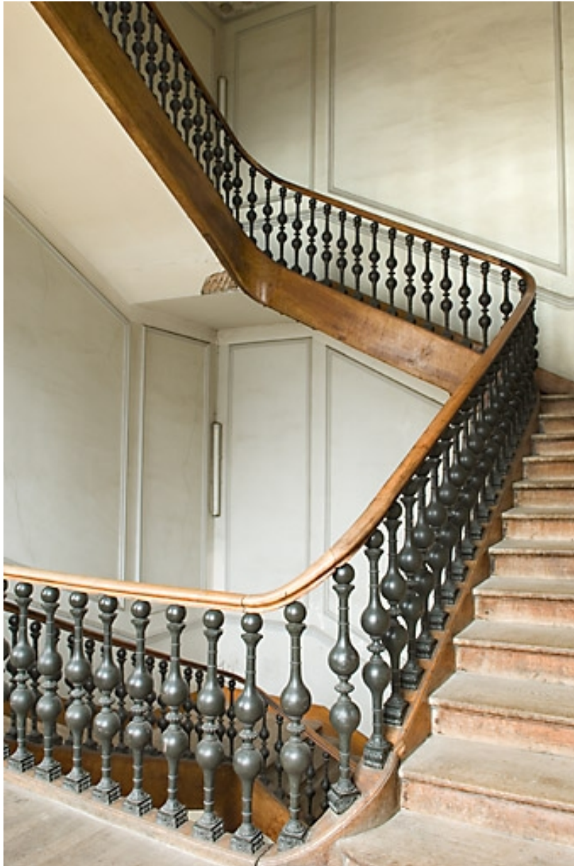
Escalier d'honneur : vue d'ensemble.
