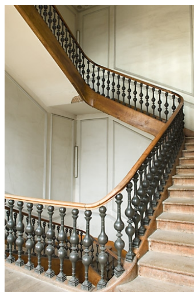
Escalier d'honneur : vue d'ensemble. Phot. Jérôme Mongreville IVR43_20082500085NUC2A
