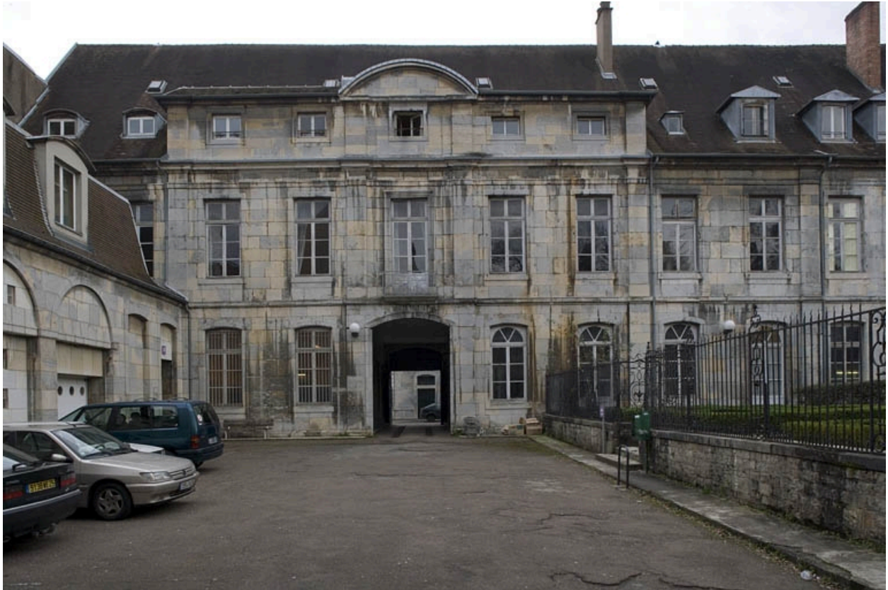
Vue de la façade sur cour.
