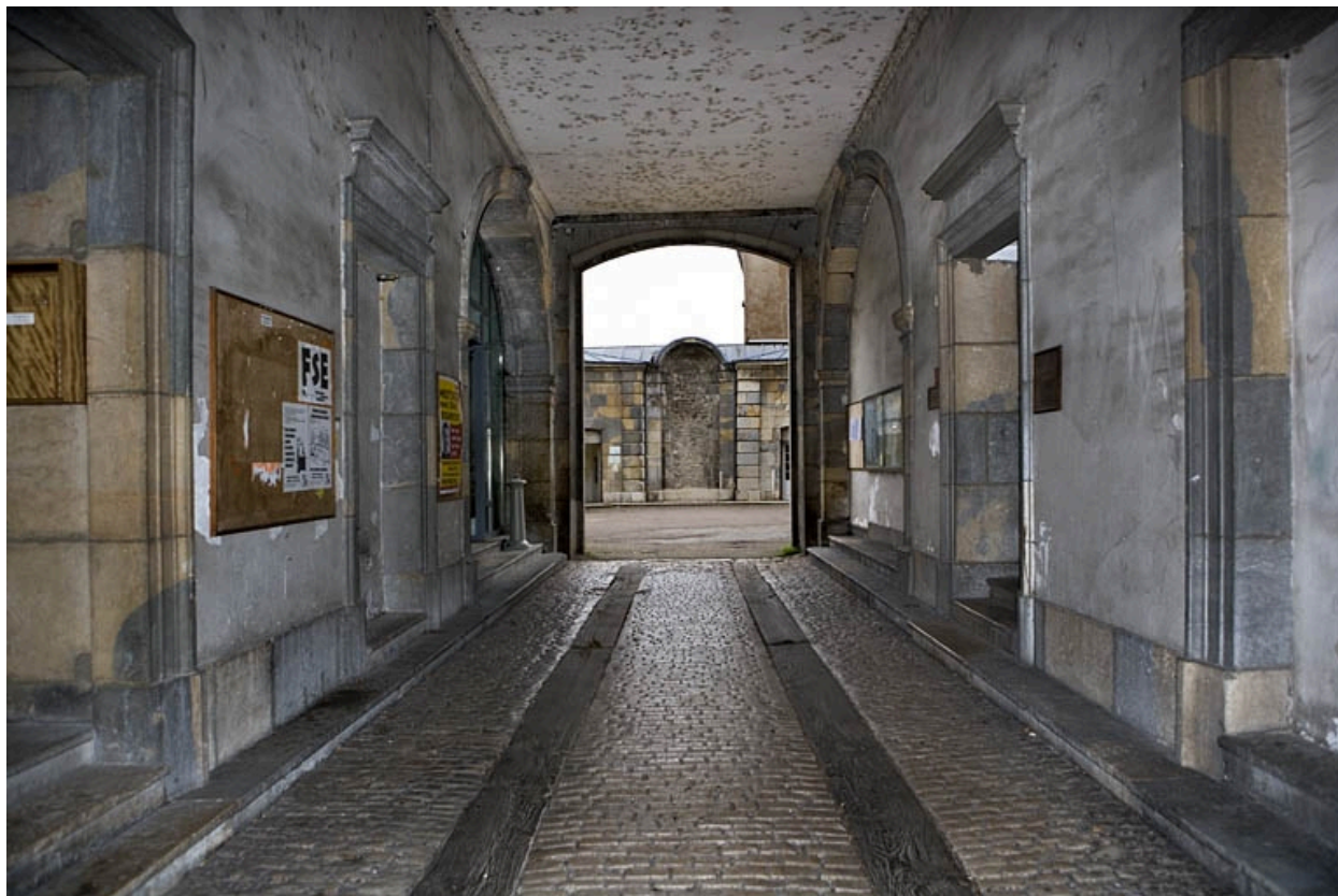
Détail du passage cocher depuis le portai d'entrée.
