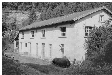
Centrale hydroélectrique. Phot. Laurent Poupard IVR43_19913901153Z
