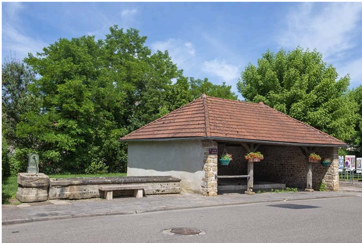
L'ensemble de la borne-fontaine, de l'abreuvoir et du lavoir, de trois quarts gauche.
