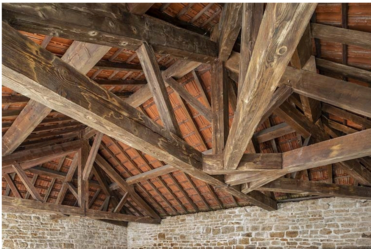
La charpente du lavoir.
