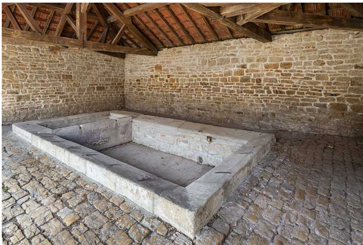
Les deux bassins du lavoir.
