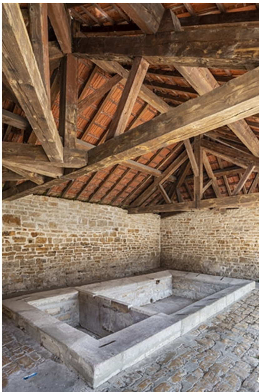
L'ensemble de l'intérieur du lavoir.
