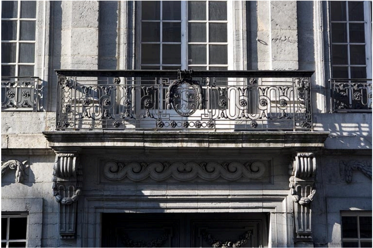
Détail du balcon en ferronnerie, au premier étage sur rue, comportant les armoiries des Terrier de Santans.
