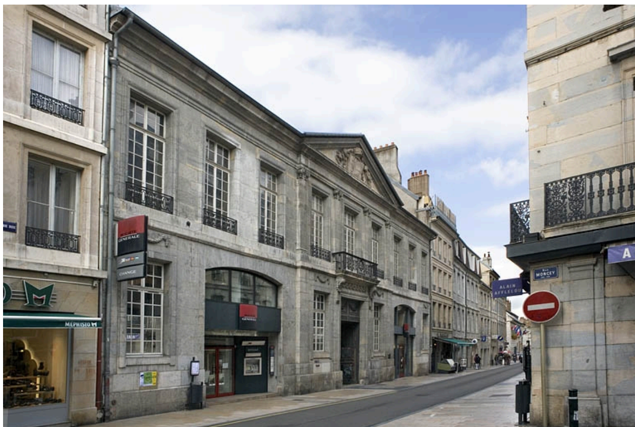
Vue d'ensemble de l'édifice de trois quarts gauche.
