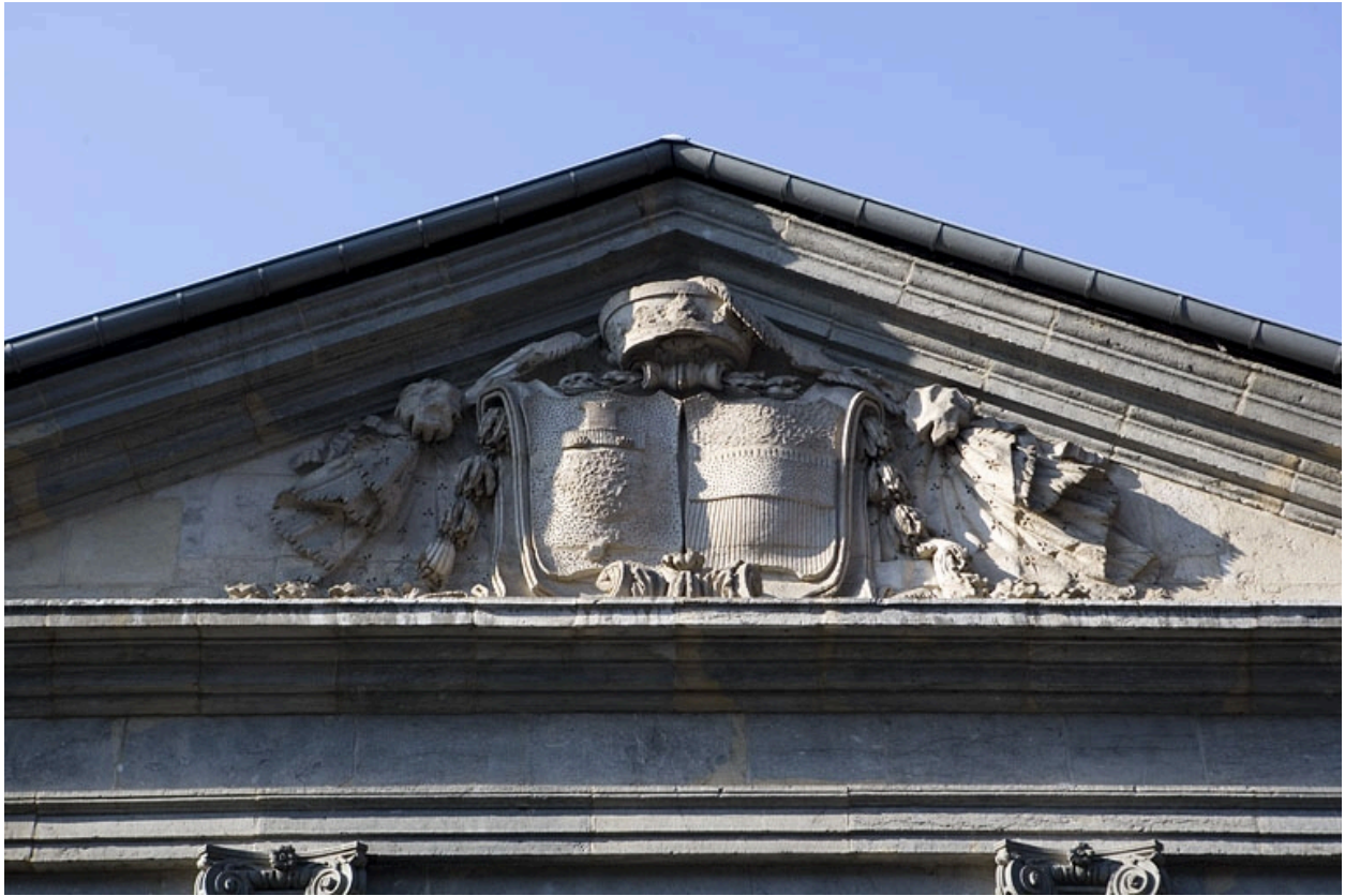
Détail des armoiries bûchées situées dans le fronton couronnant la façade sur rue.
