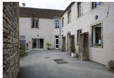
Vue d'ensemble des bâtiments situés dans la cour des communs. Phot. Yves Sancey IVR43_20082500559NUC2A
