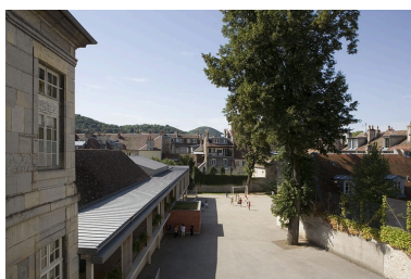
Vue d'ensemble de la cour de l'école, à l'emplacement de l'ancien jardin. Phot. Yves Sancey IVR43_20082500553NUC2A
