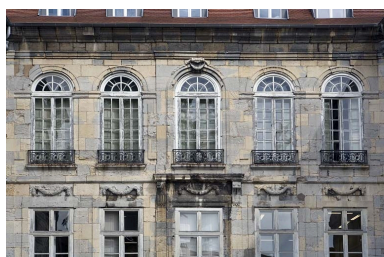
Façade postérieure du logis principal : détail de la partie centrale. Phot. Yves Sancey IVR43_20082500561NUC2A
