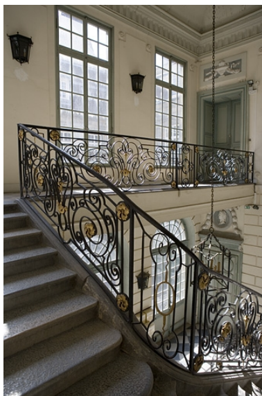
Escalier d'honneur : détail de la dernière volée et du palier. Phot. Yves Sancey IVR43_20082500549NUC2A
