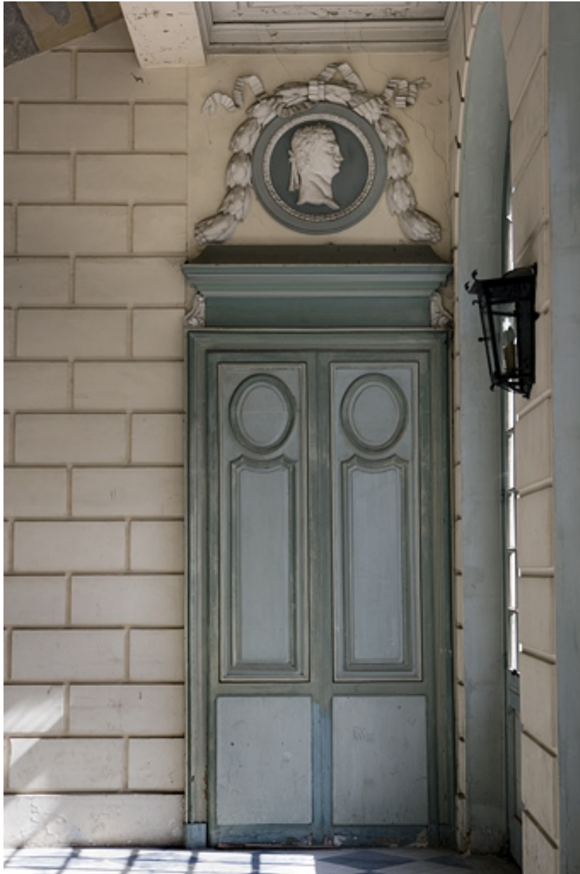
Escalier d'honneur : vue de la porte droite située au rez-de-chaussée.
