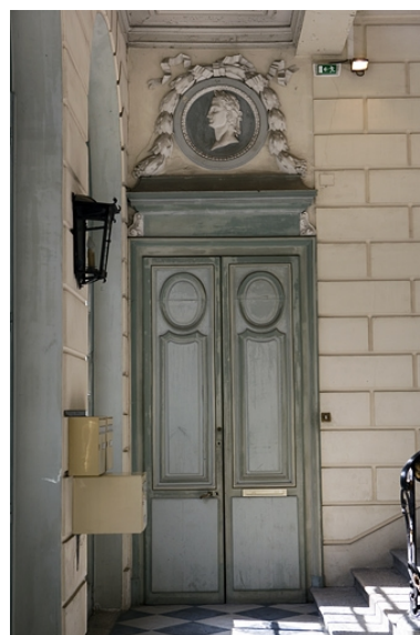
Escalier d'honneur : vue de la porte gauche située au rez-de-chaussée. Phot. Yves Sancey IVR43_20082500545NUC2A
