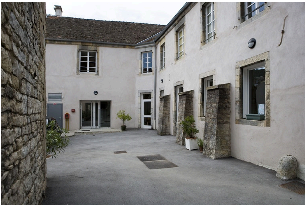
Vue d'ensemble des bâtiments situés dans la cour des communs.
