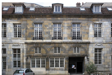
Aile à gauche de la cour d'honneur contenant le passage donnant sur la cour des communs. Phot. Yves Sancey IVR43_20082500556NUC2A
