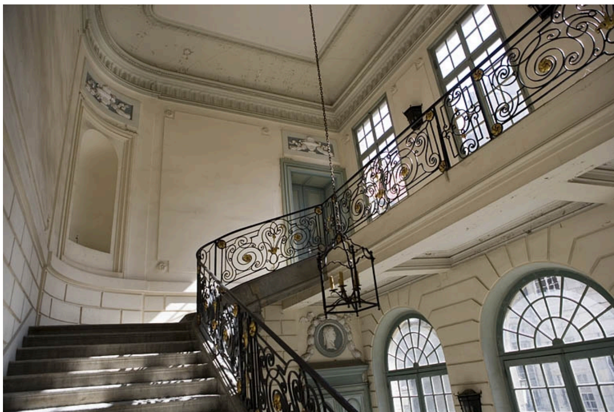
Escalier d'honneur : vue d'ensemble de la cage d'escalier depuis le haut de la dernière volée.
