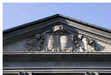
Détail des armoiries bûchées situées dans le fronton couronnant la façade sur rue. Phot. Yves Sancey IVR43_20082500617NUC2A
