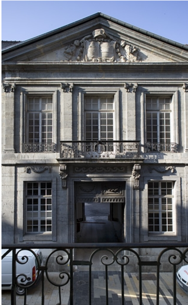
Vue d'ensemble de la partie centrale de la façade sur rue, de face.
