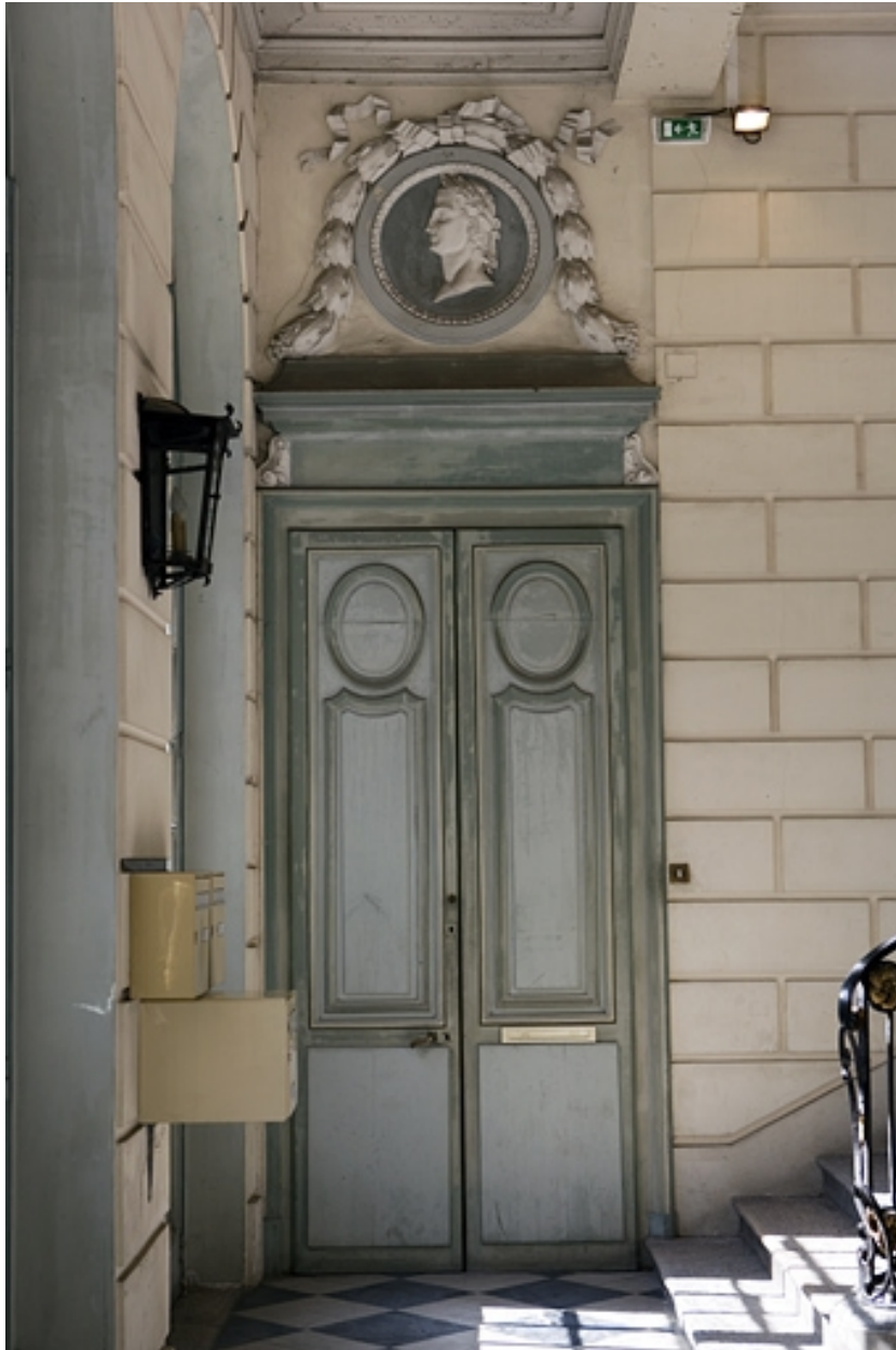
Escalier d'honneur : vue de la porte gauche située au rez-de-chaussée.
