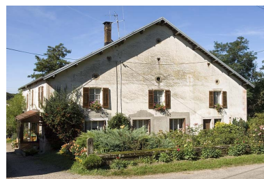
Ferme et logement. Phot. Jérôme Mongreville IVR43_20067000765NUCA
