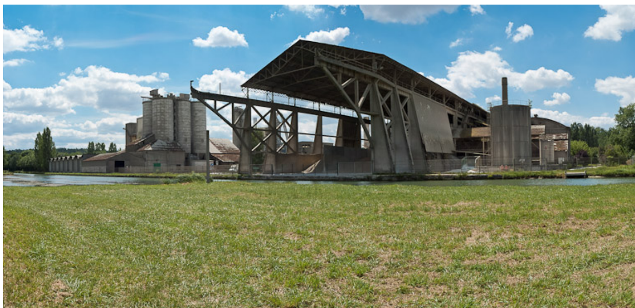
Vue du pont-roulant de la cimenterie.
