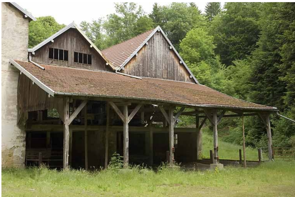
Façade et appentis sud.
