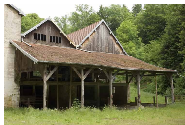
Façade et appentis sud. Phot. Jérôme Mongreville IVR43_20087000569NUC2A
