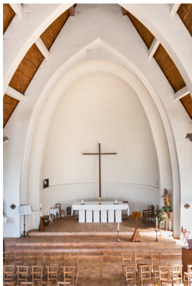
Vue d'ensemble du chœur et de son mobilier. Phot. Pierre-Marie Barbe-Richaud IVR26_20248900105NUC4A
