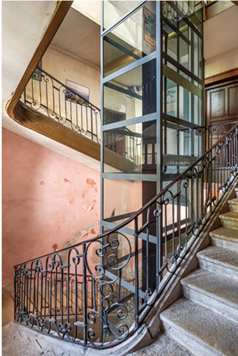
La cage d'escalier depuis le second repos.
