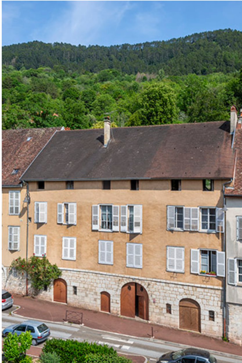
Façade antérieure vue depuis l'ouest.
