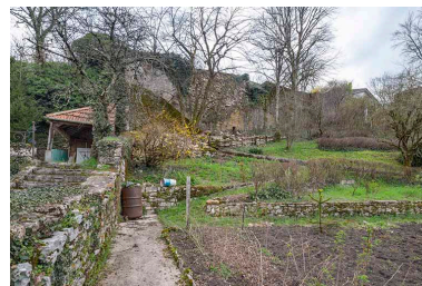
Vue depuis la seconde terrasse. Partie talutée menant au rempart. Phot. Jérôme Mongreville IVR43_20233900155NUC4A
