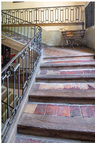
Volée d'escalier entre le premier et le second étage. Phot. Jérôme Mongreville IVR43_20233900704NUC4A
