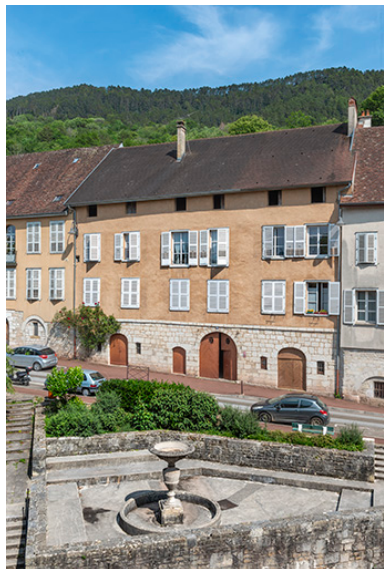
Vue d'ensemble depuis l'ouest. Phot. Jérôme Mongreville IVR43_20233900709NUC4A
