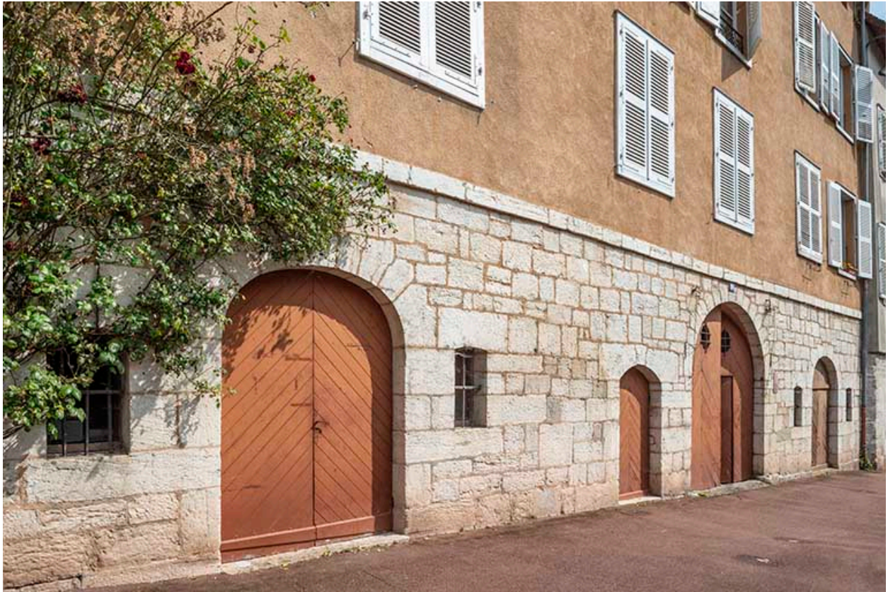
Les ouvertures au rez-de-chaussée.
