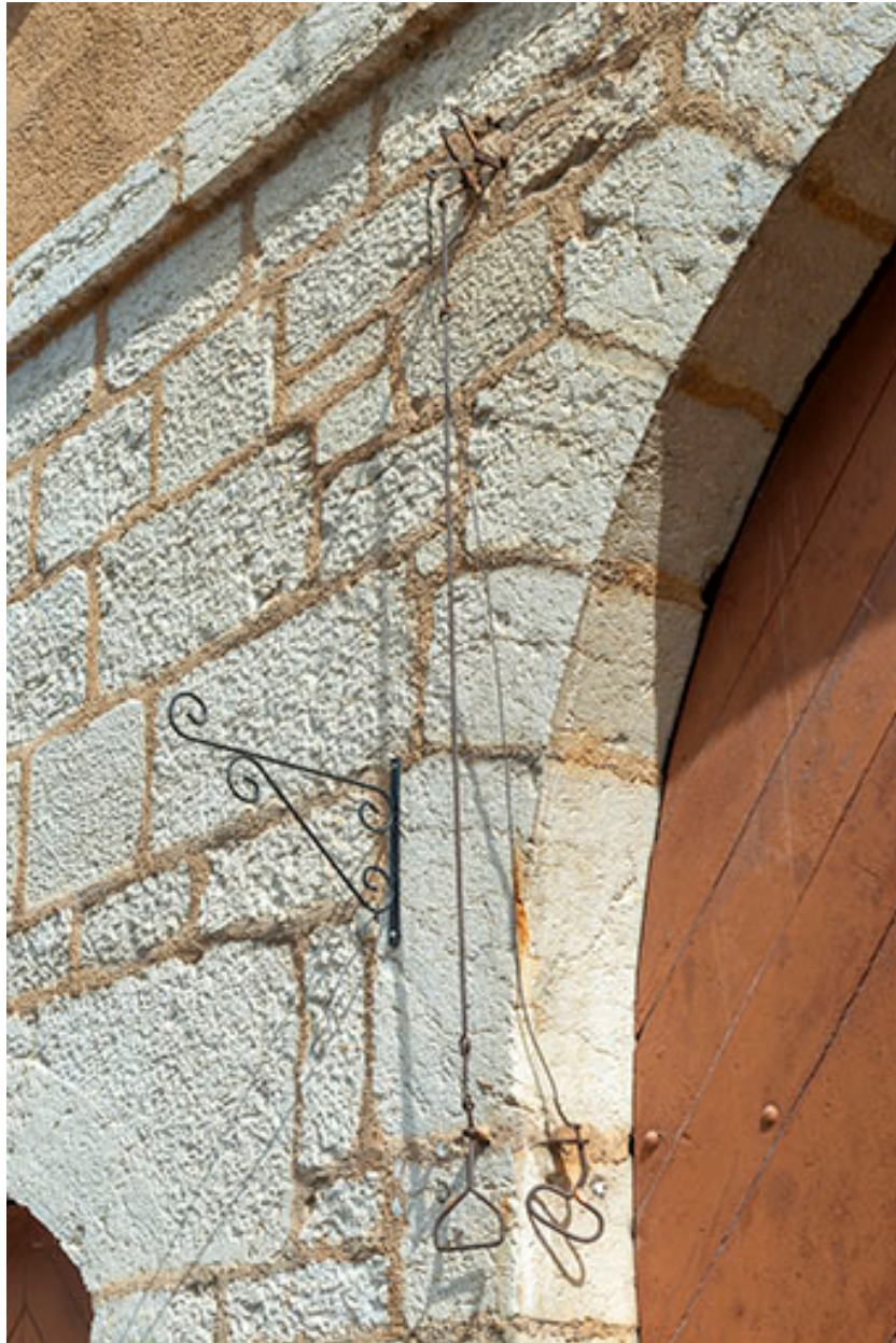
Système de sonnette (clochette) de portes intérieures depuis la rue (poignées, relais et fil de fer).
