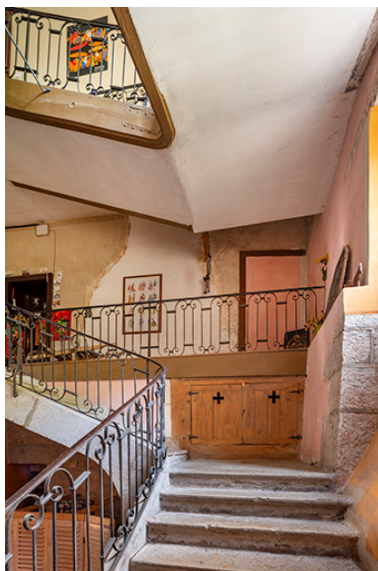
L'escalier vu depuis le premier repos. Phot. Jérôme Mongreville IVR43_20233900701NUC4A
