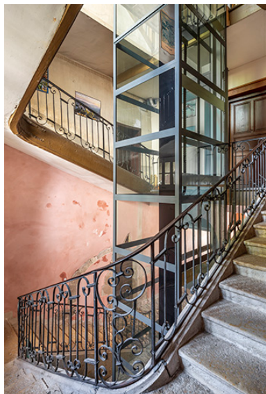
La cage d'escalier depuis le second repos. Phot. Jérôme Mongreville IVR43_20233900703NUC4A
