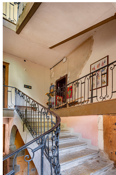
Cage d'escalier depuis la seconde volée. Phot. Jérôme Mongreville IVR43_20233900702NUC4A
