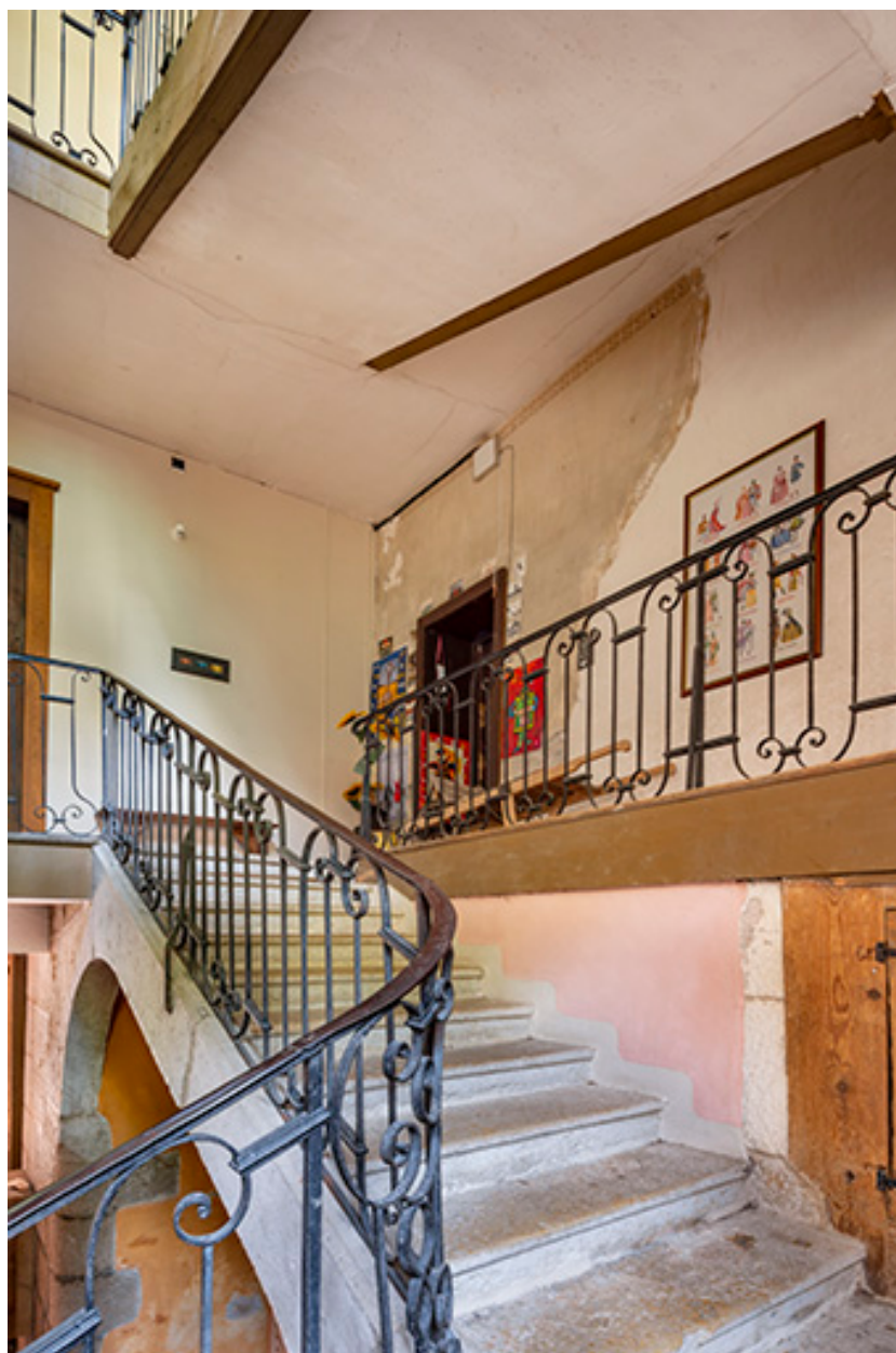
Cage d'escalier depuis la seconde volée.
