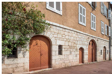
Les ouvertures au rez-de-chaussée. Phot. Jérôme Mongreville IVR43_20233900717NUC4A
