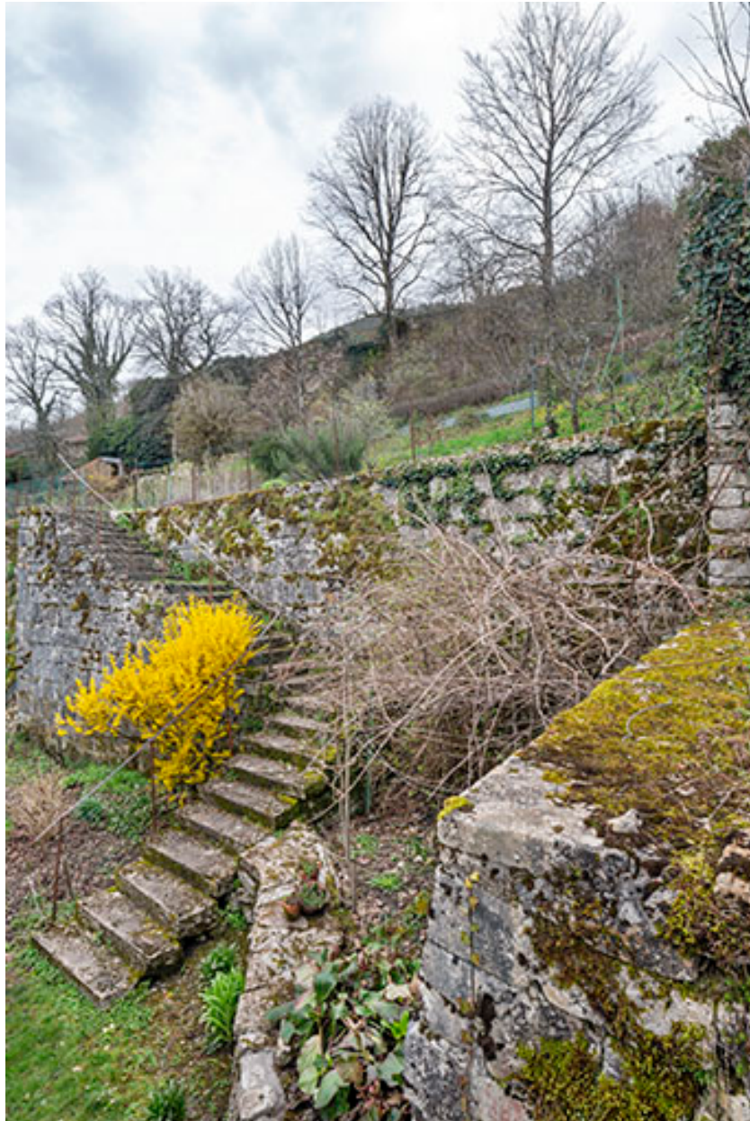
L'escalier d'accès à la première terrasse.
