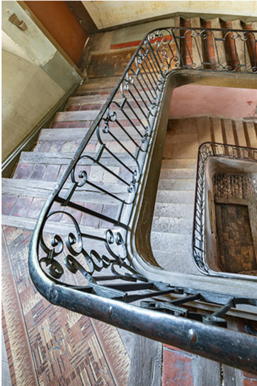
Vue plongeante sur la cage d'escalier.
