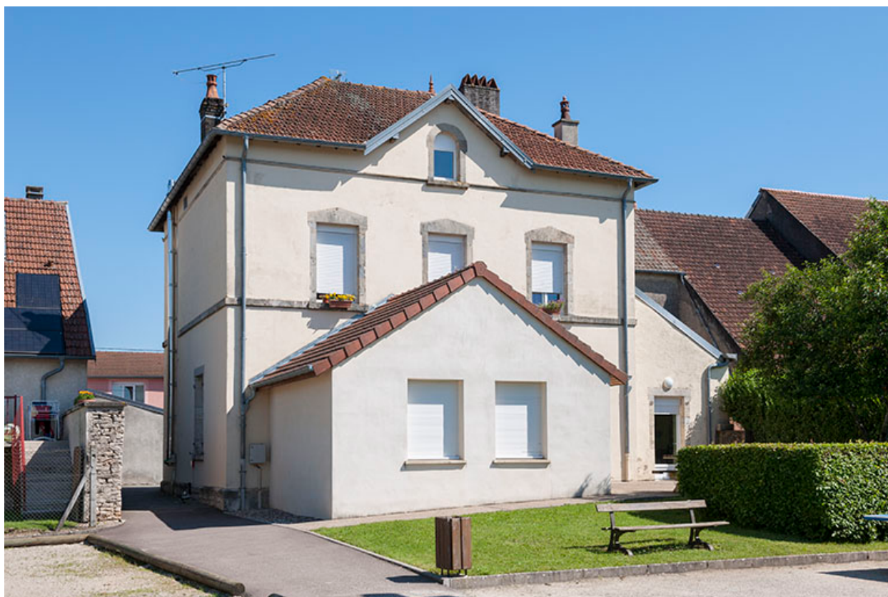
Façade postérieure avec l'agrandissement contemporain.
