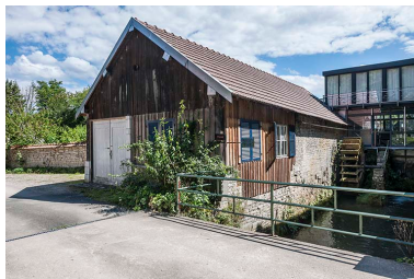
L'atelier de fabrication et la roue hydraulique. Phot. Jérôme Mongreville IVR43_20142501268NUC4A
