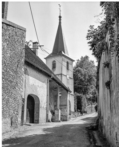
Façade antérieure : vue d'ensemble de trois quarts.
