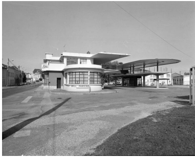
Façade latérale droite de trois quarts gauche.
