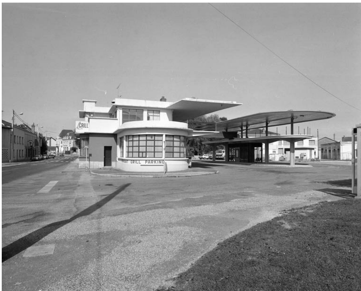
Façade latérale droite de trois quarts gauche.
