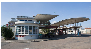
Gare et auvents. Phot. Yves Sancey IVR43_20067000886NUCA
