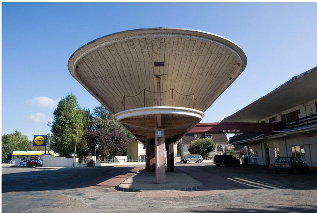
Auvent en béton.
