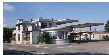
Gare et auvents. Phot. Yves Sancey IVR43_20067000885NUCA
