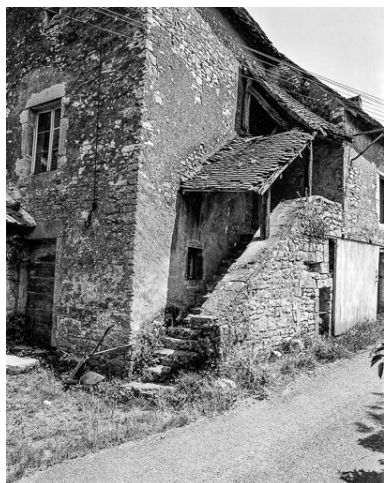
Détail de l'escalier. Phot. Dominique Humbert IVR43_19767000446X
