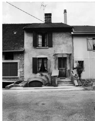
Maison de vigneron située rue Roche. Phot. Yves Sancey IVR43_19813900266X
