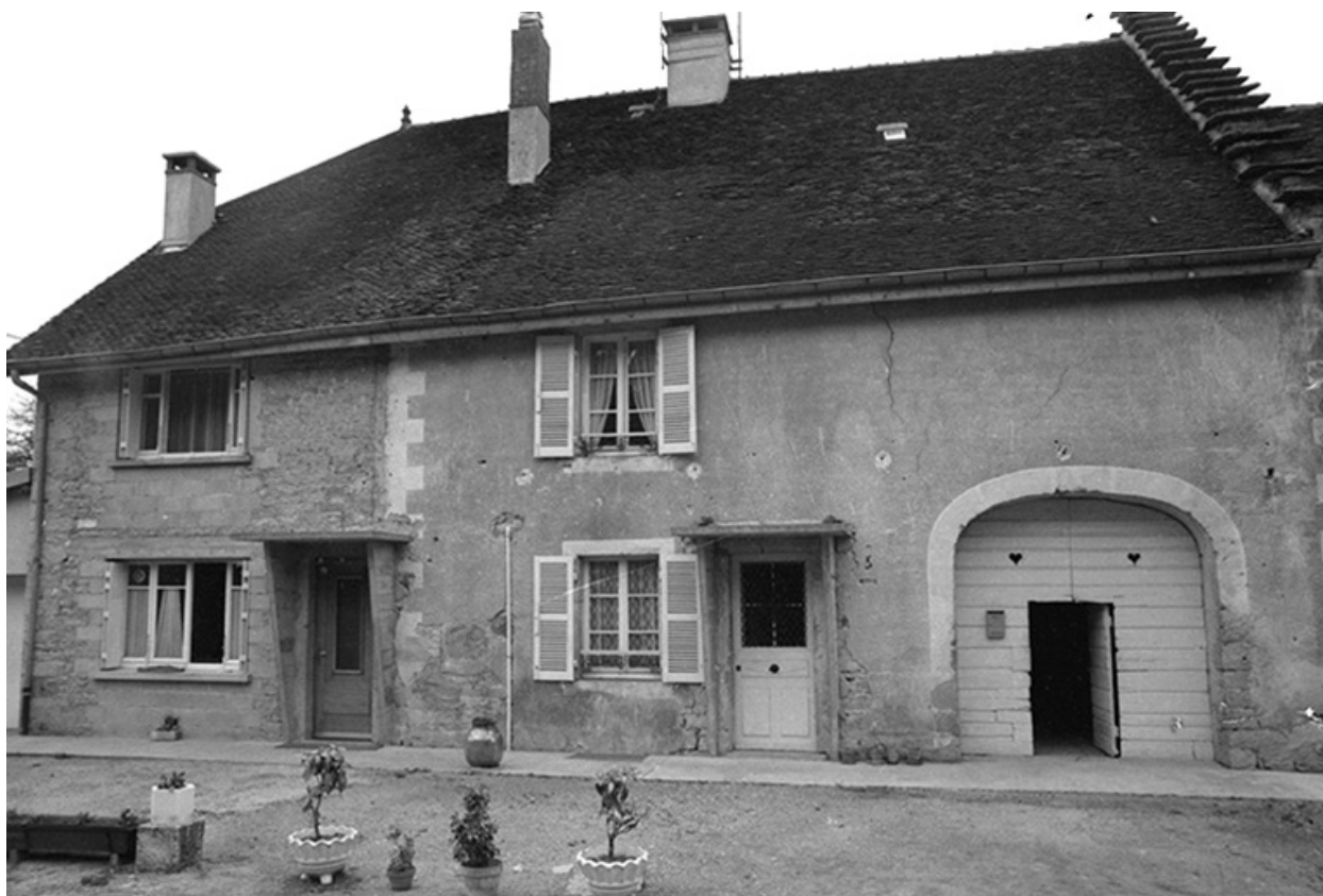
Maison située rue des Guichard.
