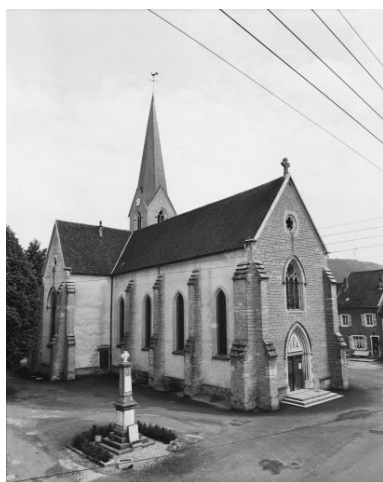
Eglise paroissiale Saint-Gervais et Saint-Protais. Phot. Yves Sancey IVR43_19753900028X
