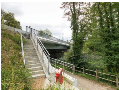
Vue d'ensemble du pont.
