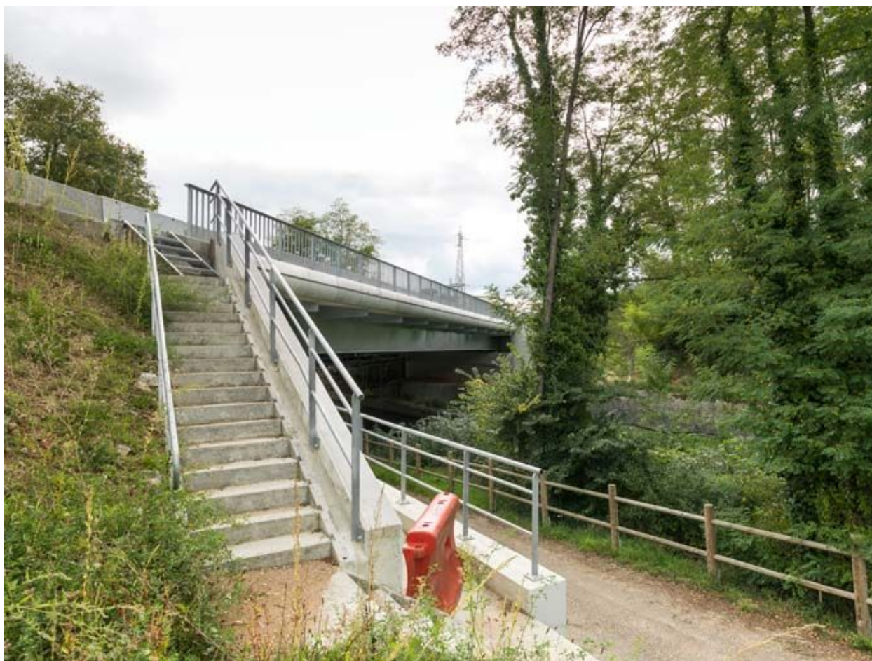
Vue d'ensemble du pont.
