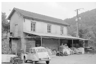
Ancien atelier de fabrication. Phot. Laurent Poupard IVR43_19903900519Z
