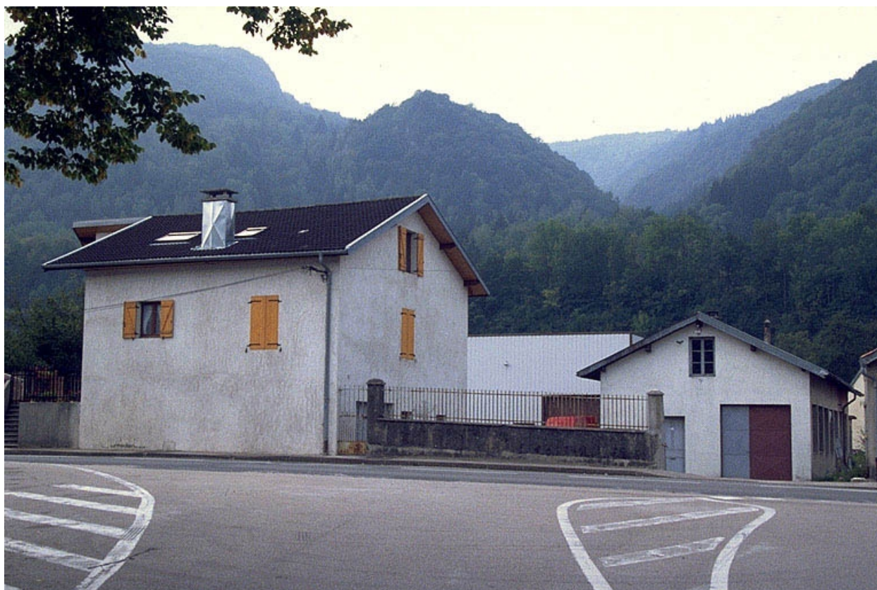
Entrée de l'usine.
