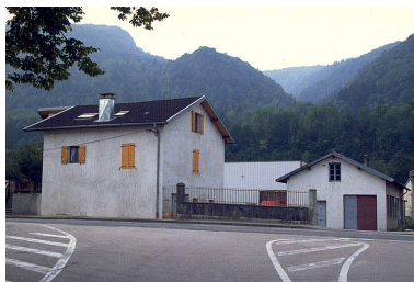
Entrée de l'usine. Phot. Laurent Poupard IVR43_19903900517ZA
