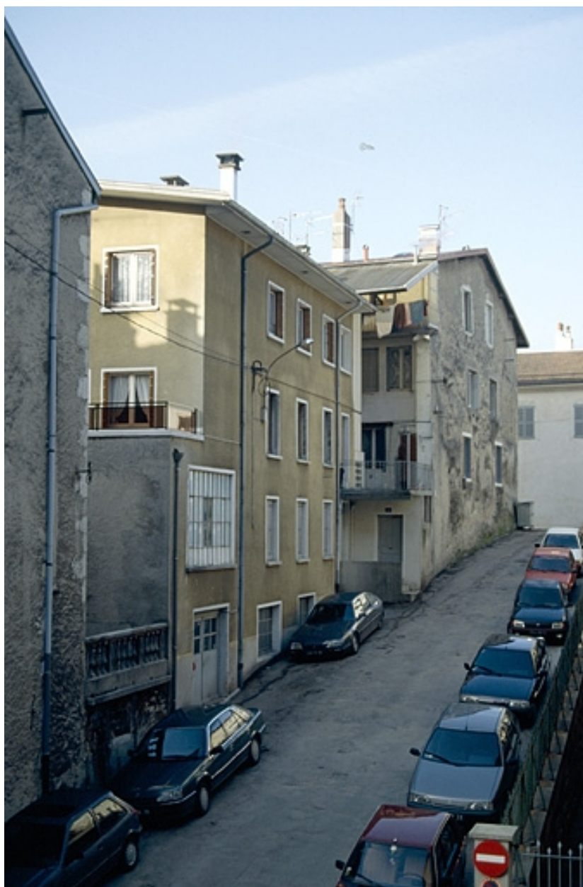
Façade antérieure de trois quarts gauche.
