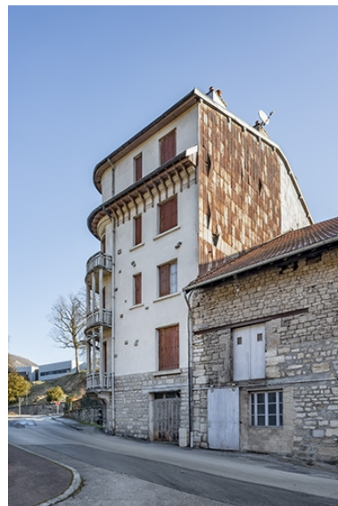
Vue depuis le sud-ouest. Phot. Jérôme Mongreville IVR43_20223900280NUC4A
