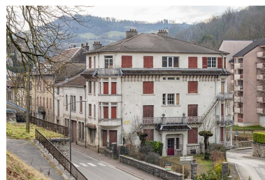
Façade principale, angle de la rue Gambetta (à gauche) et de la rue des Barres (à droite). Phot. Jérôme Mongreville IVR43_20223900283NUC4A
