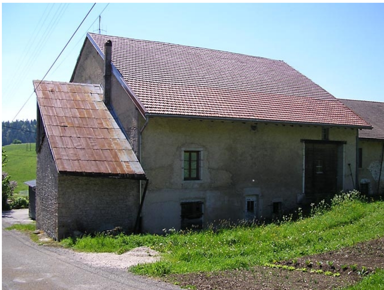
Façade postérieure et remise.
