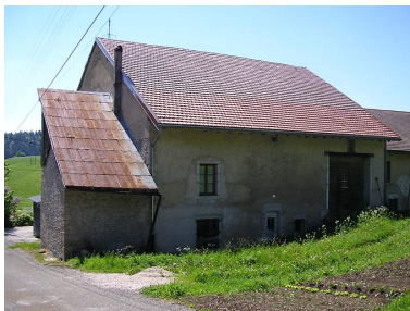
Façade postérieure et remise.
