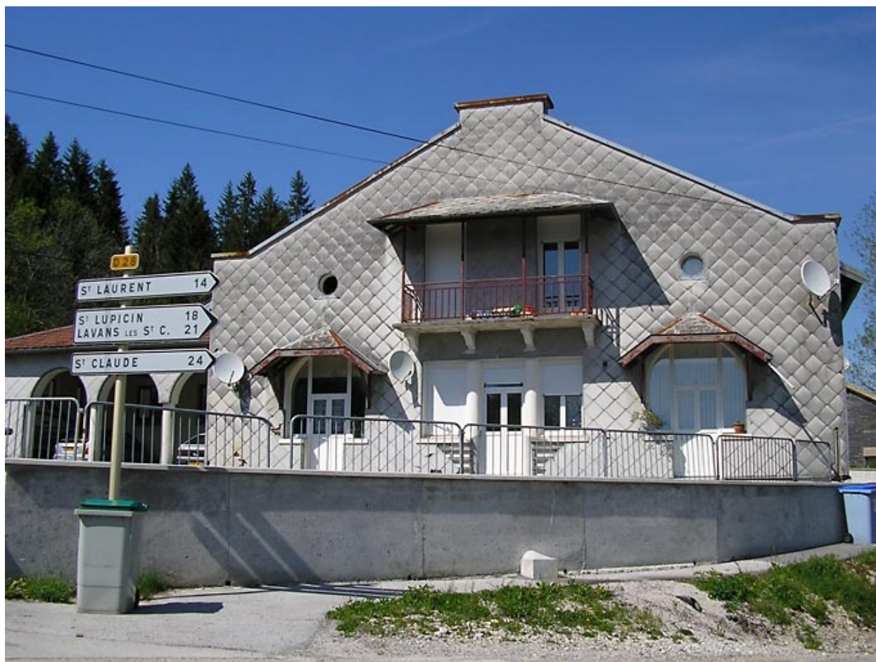
Le pignon sud-ouest et l'ancien préau.
