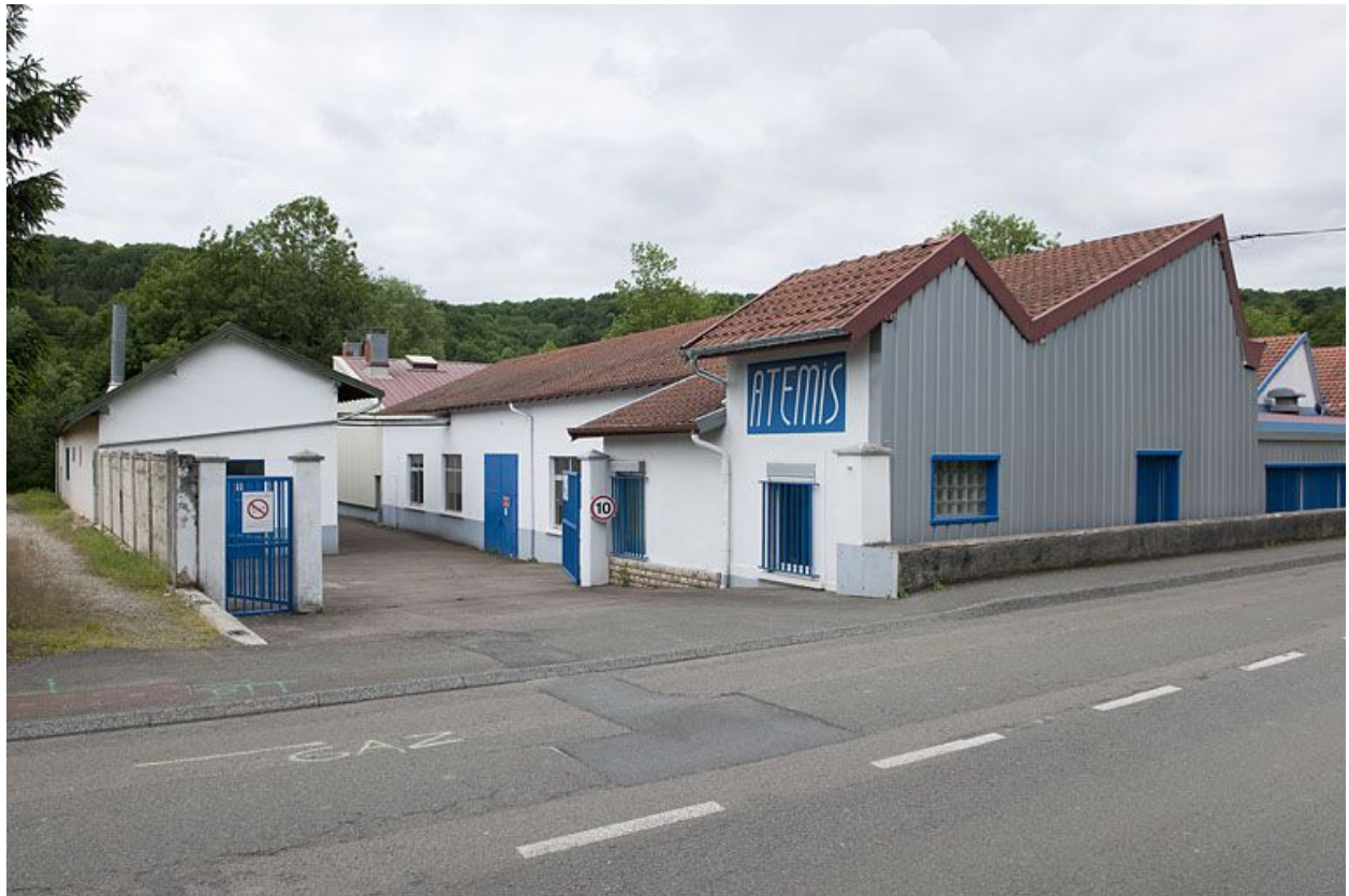
Bureau et atelier depuis le sud-est.
