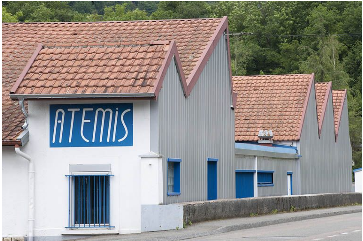
Pignons des sheds sur la route.
