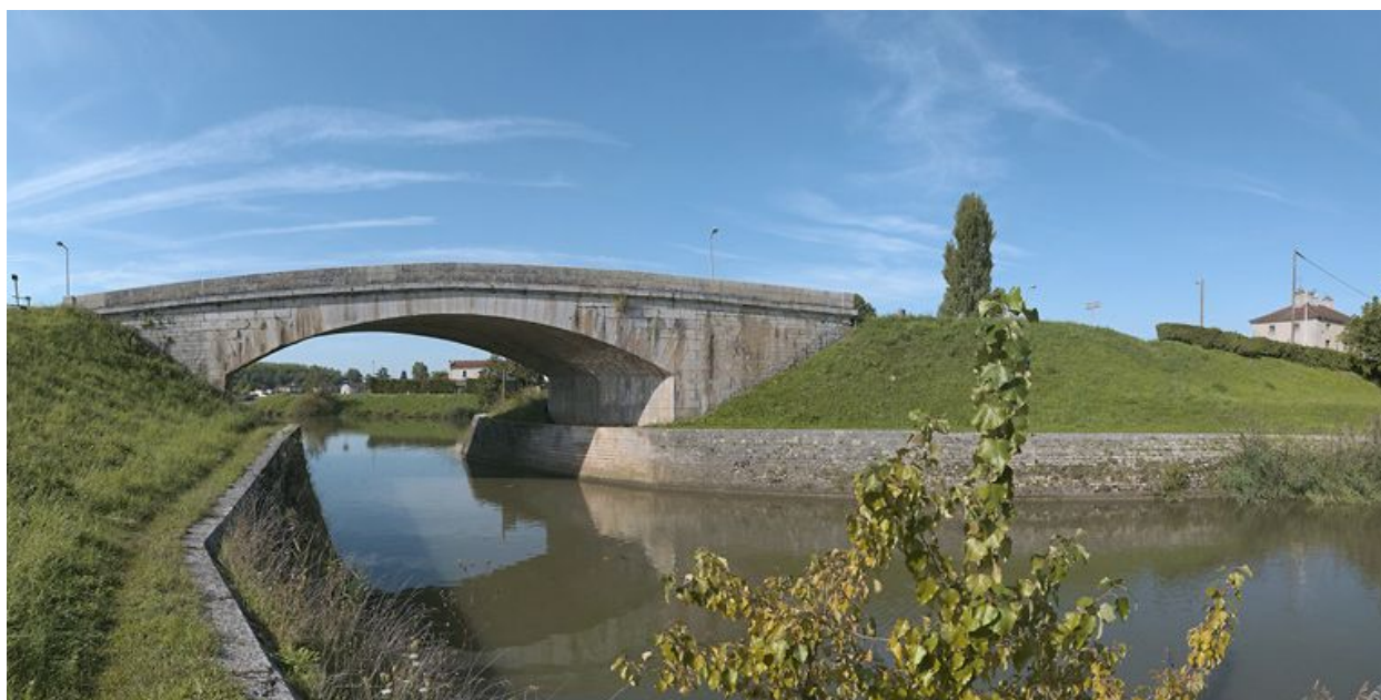
Vue d'ensemble prise d'aval.
