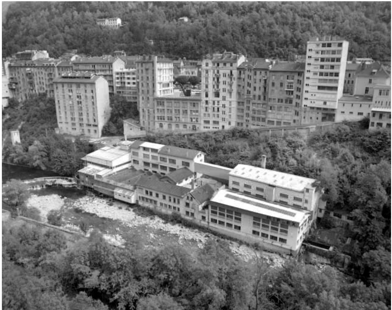
Vue plongeante depuis l'ouest.
