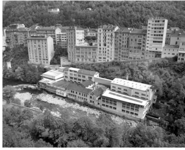
Vue plongeante depuis l'ouest.
