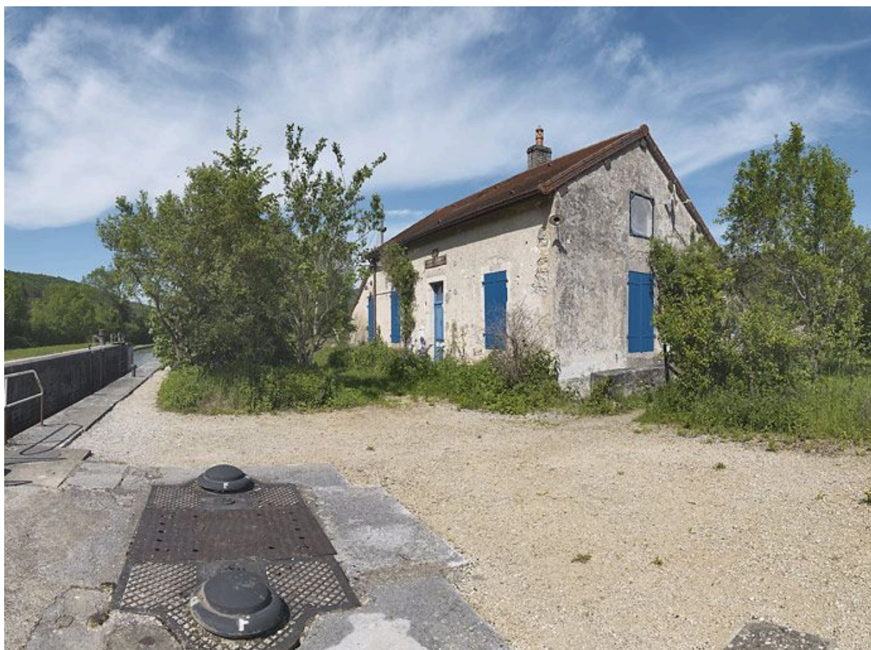
Maison éclusière de 3/4.
