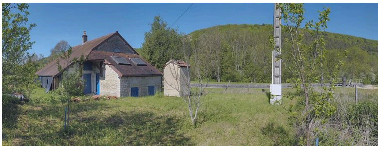
Les annexes de la maison éclusière.
