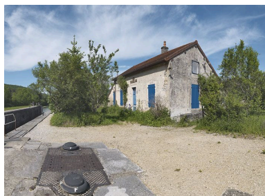
Maison éclusière de 3/4. Phot. Thierry Kuntz IVR26_20122102400NUC4AQ
