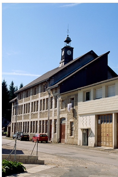
Façade antérieure de l'atelier de fabrication.
