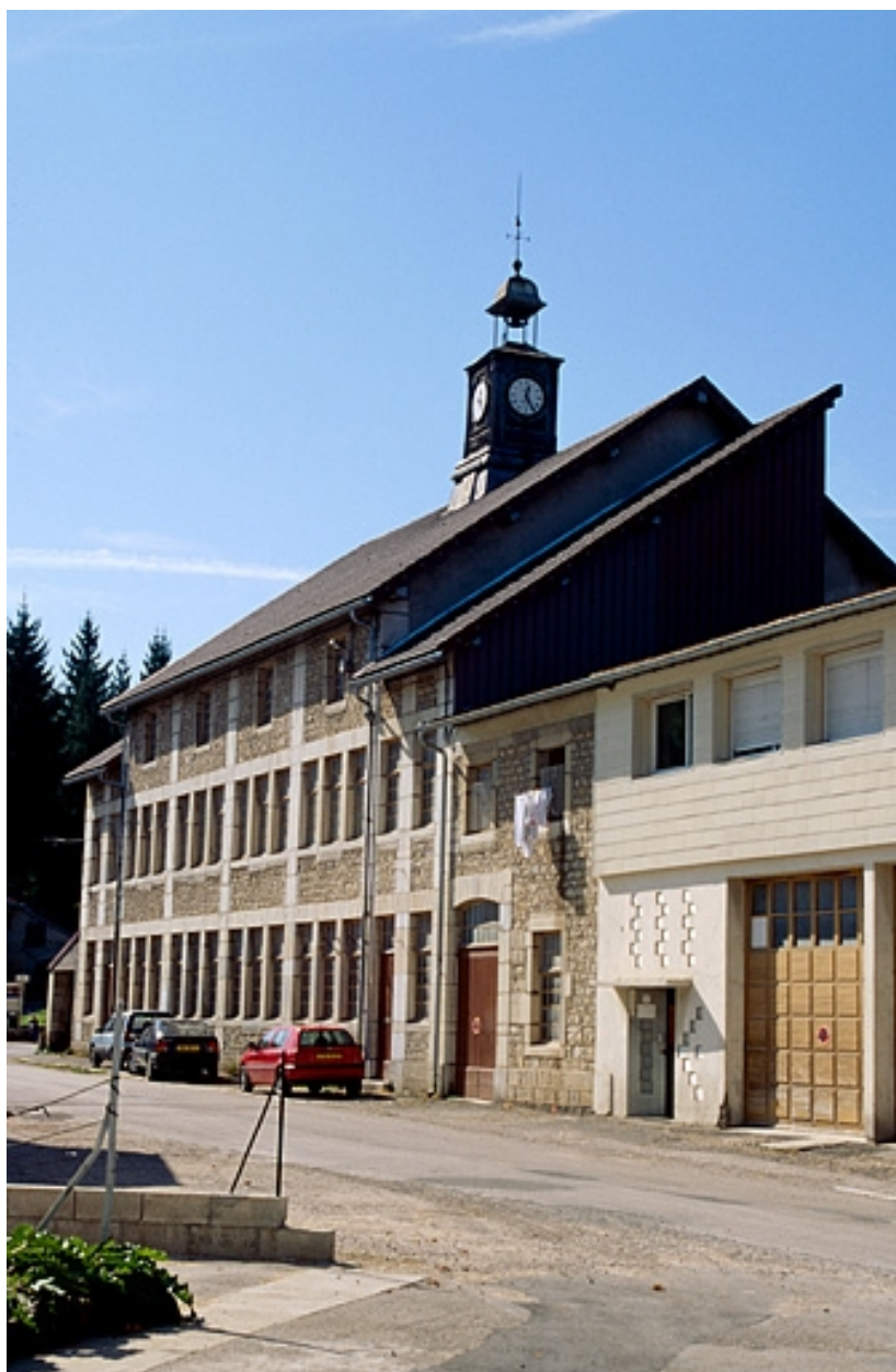
Façade antérieure de l'atelier de fabrication.
