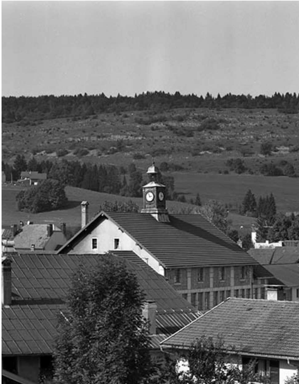
La toiture de l'usine depuis le sud-est.
