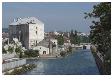
Les bâtiments en cours de démolition.
