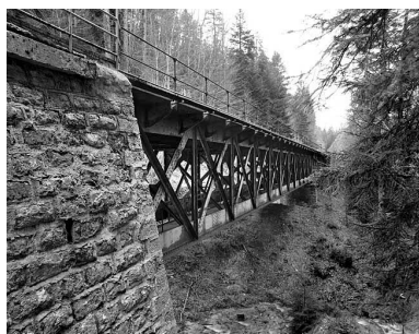
Viaduc : l'extrémité sud (vers La Cluse), côté vallée.
