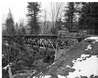
Viaduc : l'extrémité sud (vers La Cluse), côté rocher.
