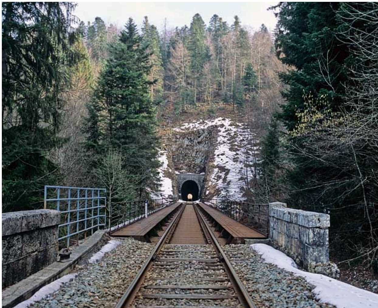
Vue d'ensemble depuis la voie, côté Andelot-en-Montagne.
