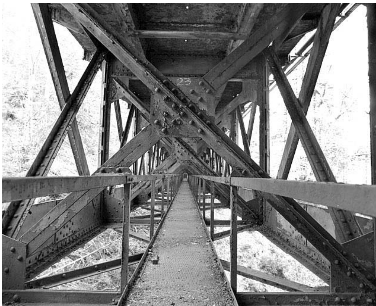
Viaduc : passerelle sous le tablier.
