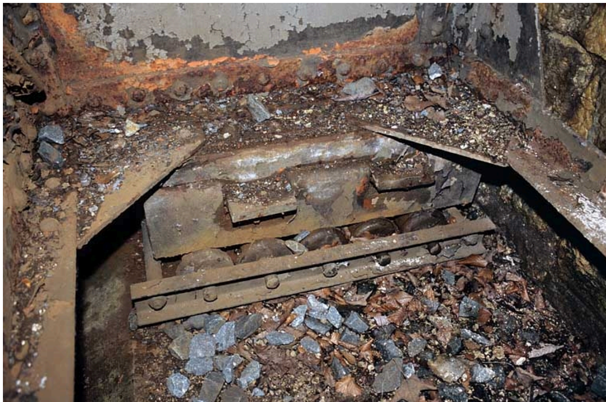
Viaduc : appareil d'appui mobile à 5 galets de roulement.
