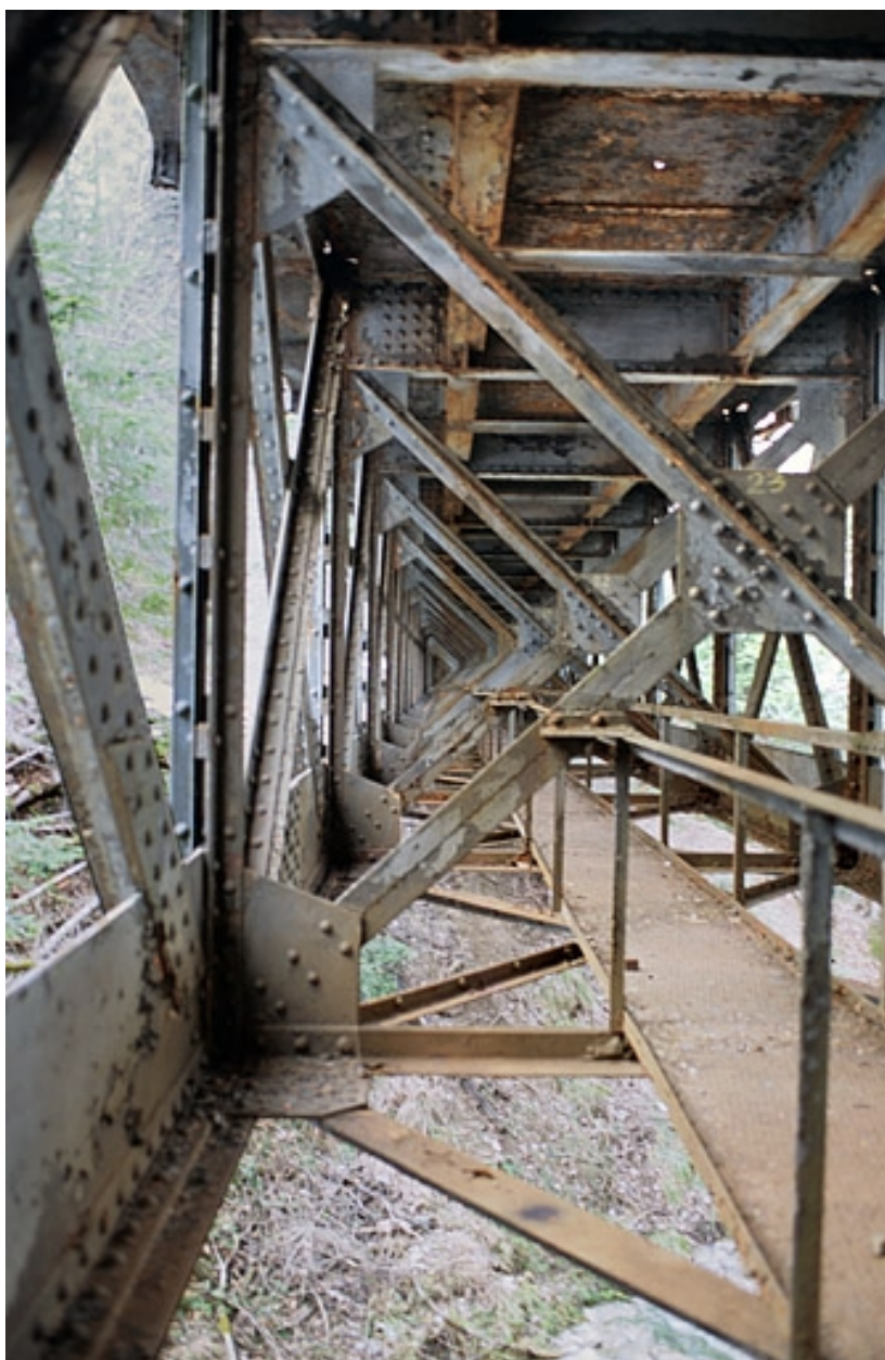
Viaduc : passerelle sous le tablier (vue désaxée à gauche).
