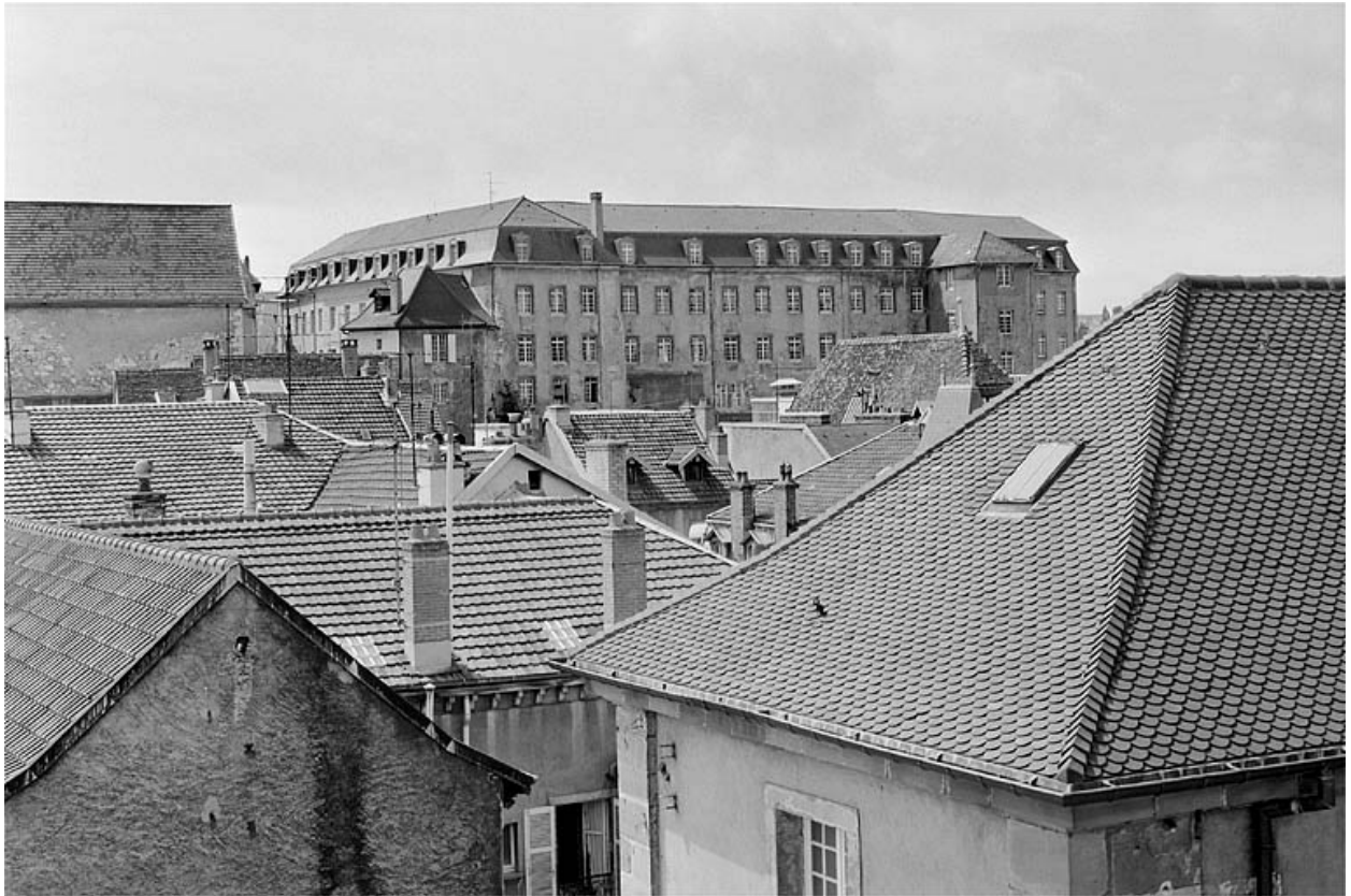
Vue d'ensemble, côté nord.
