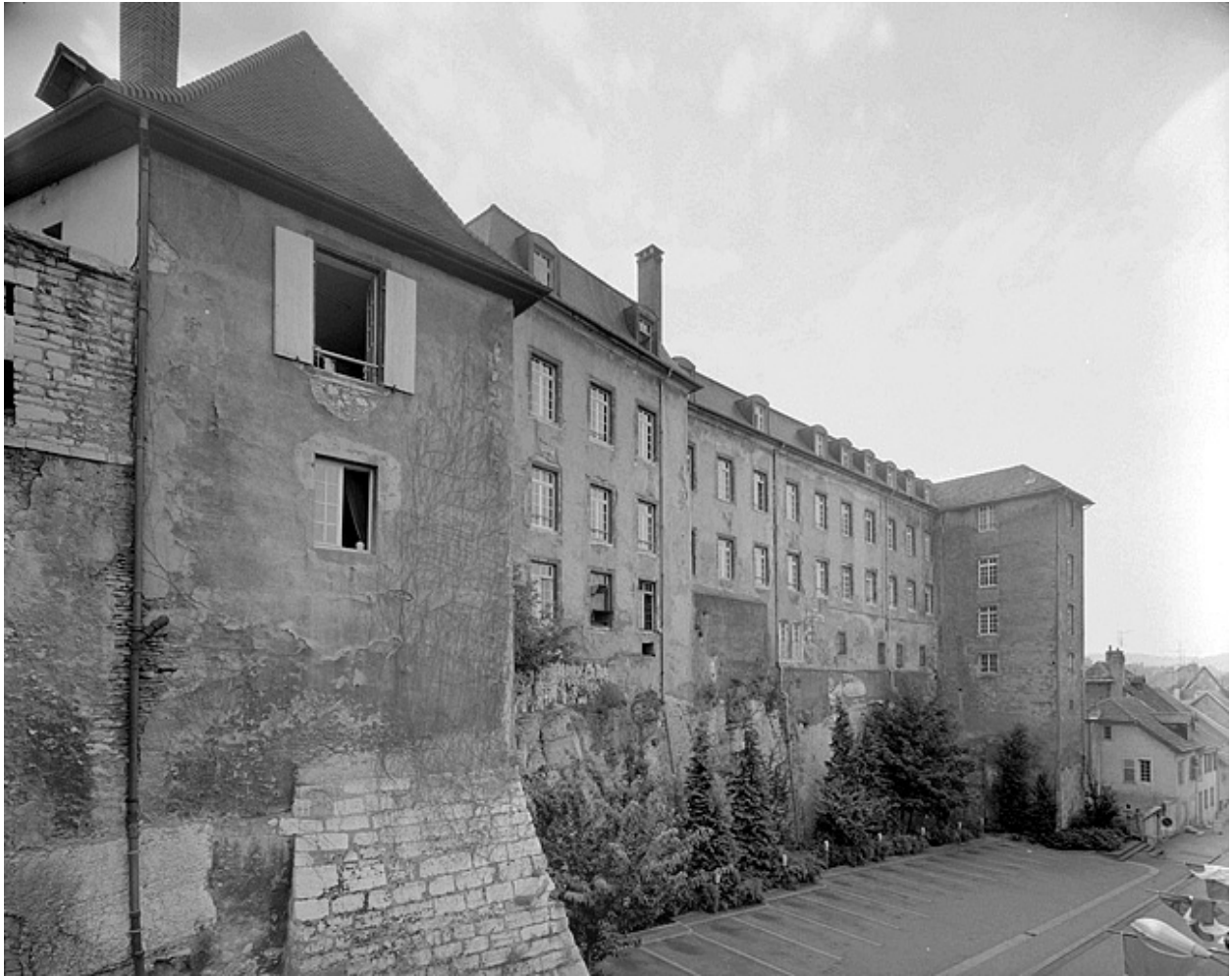
Façade nord et tour du Puits au fond.
