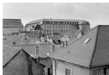
Vue d'ensemble, côté nord. Phot. Jérôme Mongreville IVR43_19872500331X
